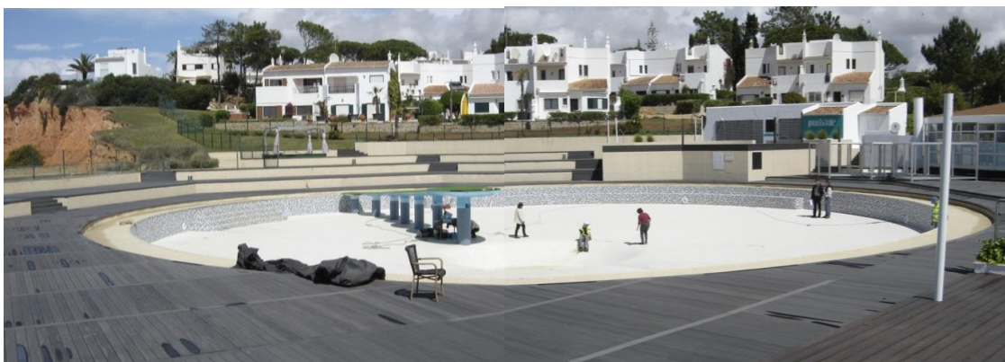
Figura 3 – Vista geral sobre a piscina
