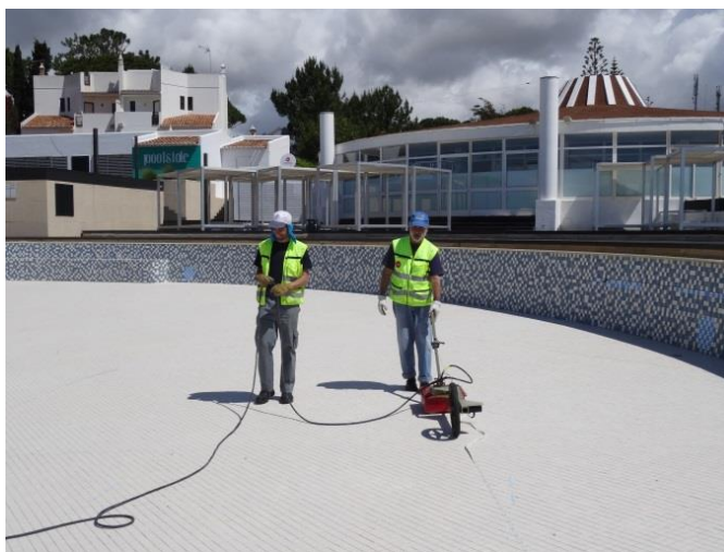
Figura 6 – Equipamento usado para execução dos perfis
