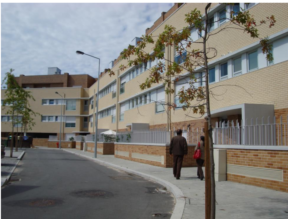
Fig. 10 e Fig.11: Av. Salgado Zenha, Guifões, Matosinhos, Cooperativa As Sete Bicas, 2008, 40 fogos e uma residência/lar de terceira idade com 30 quartos, projeto dos arquitectos Fernando Rocha e Celestino Machado.
