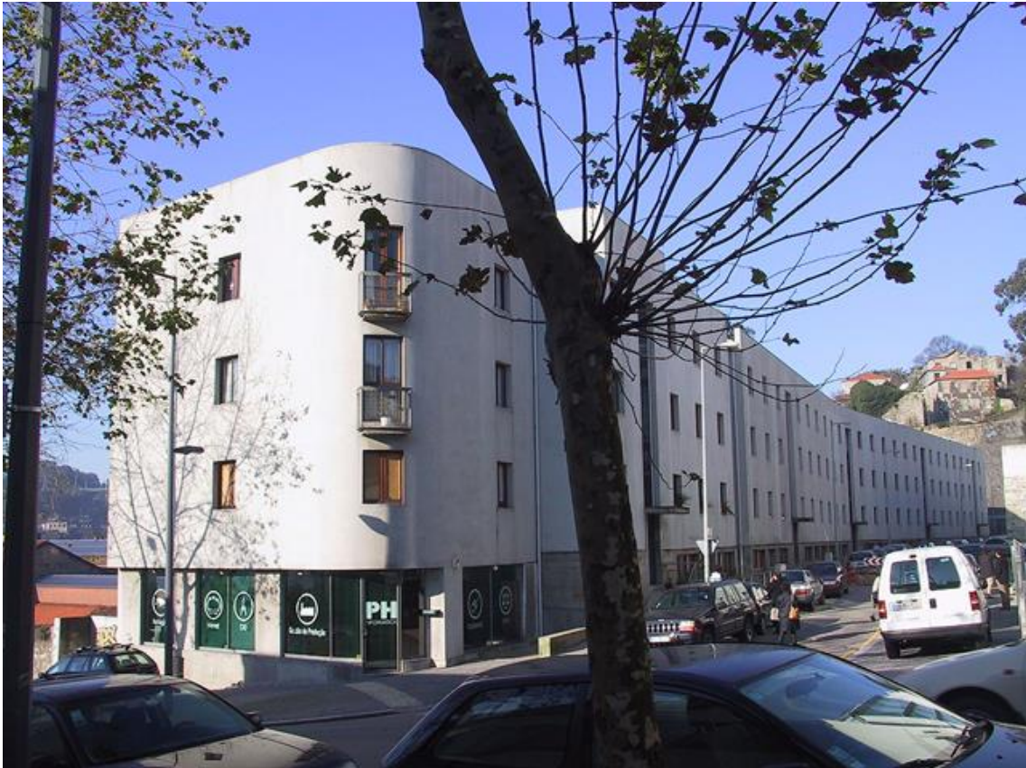
Fig. 2: Cooperativa de Habitação Massarelos, no Porto, 95 fogos.
