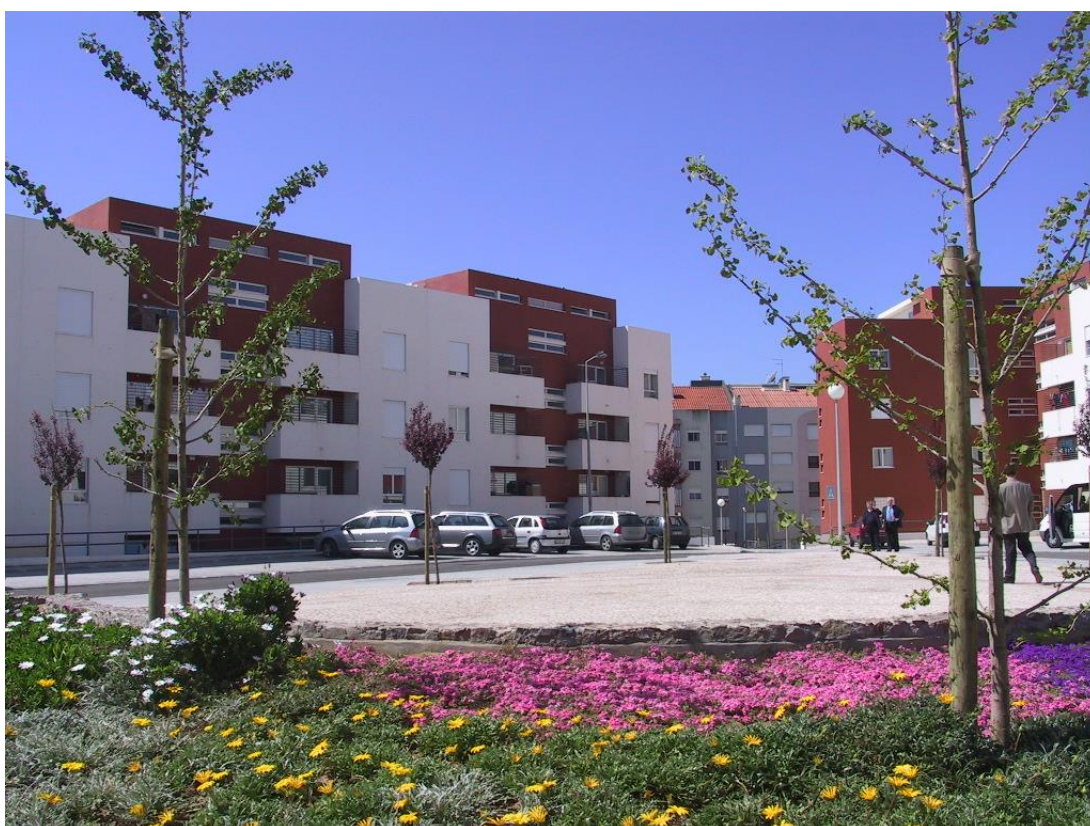
Fig. 1: conjunto de 68 fogos da NHC – Nova Habitação Cooperativa, no Plano Integrado do Zambujal, Amadora, projecto coordenado pelo Arq.º Carlos Carvalho, 2003 – um processo de promoção completo, que incluiu a contratação de uma garantia de dez anos, relativa aos principais aspectos construtivos e que integrou todas as especialidades técnicas, desde a arquitectura paisagista à montagem da gestão global a realizar depois da ocupação dos fogos; outro aspecto muito relevante tem a ver com a clara função de integração e dinamização social que este conjunto assumiu numa envolvente urbana socialmente sensível; e a nível de pormenores habitacionais temos, por exemplo, excelentes espaços de cozinha (bancadas em “U”) e estratégicas varandas.
