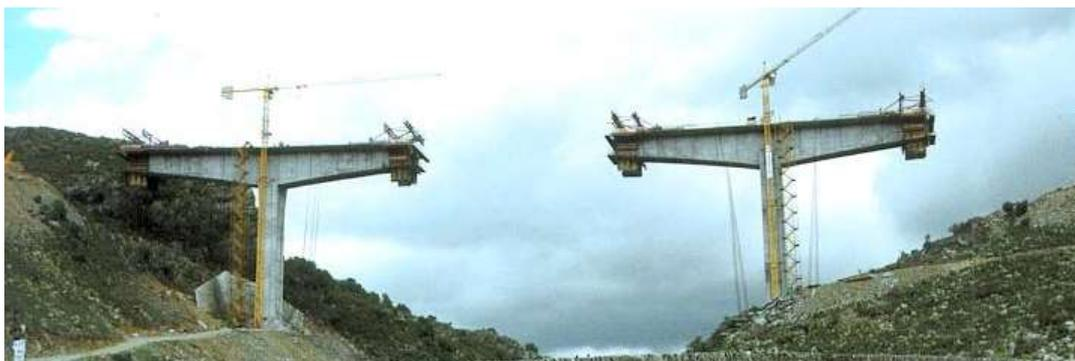
Figura 1. As pontes construídas por avanços em consola estão particularmente vulneráveis à ação do vento e ação sísmica durante a construção
