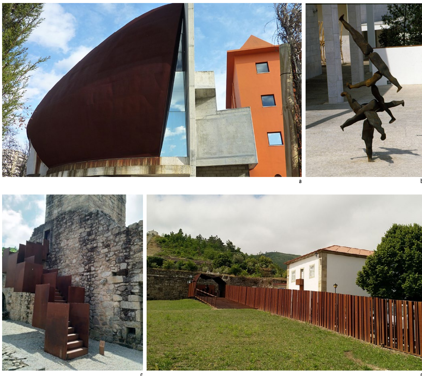
Figura 6 Exemplos de aplicações dos aços patináveis em arquitetura: a. Revestimento de cobertura, Igreja Paroquial de S. Francisco Xavier, Lisboa/Restelo. Fotografia da autora; b. Escultura “Rizome” de Antony Gormley, Parque das Nações, Lisboa, Tiago Venâncio, 1998-06-20. AML, PT/AMLSB/PAE/GFOT/01/040/009487; c. e d. Sistemas de acesso em património reabilitado. Fotografias da autora.
