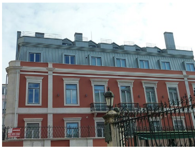
Figura 12 Exemplos da aplicação de chapa de zinco no revestimento de fachadas e coberturas: a. Edifício antigo (reabilitado) no Bairro Alto, Lisboa, 2020. Fotografia da autora; b. Pavilhão da Utopia (atual Pavilhão Atlântico), Parque das Nações, Lisboa, Fotografia de Bruno Portela, 1998-09-09. AML, PT/AMLSB/PAE/GFOT/01/170/170053.
