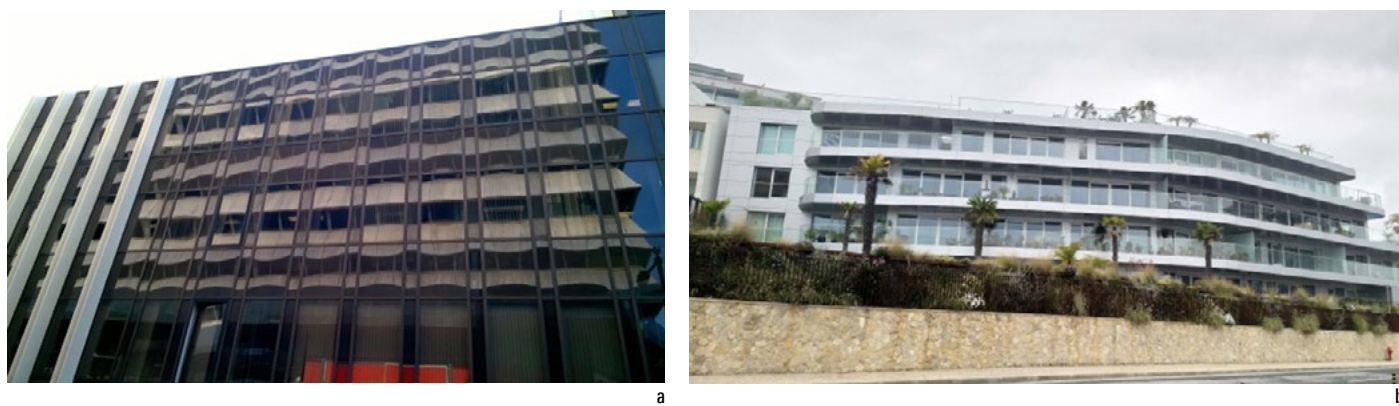
Figura 10 Aplicação típica do alumínio em componentes de fachada – caixilharia: a. Edifício de escritórios em ambiente urbano, Lisboa. Alumínio anodizado cor bronze, década de 1980; b. Edifício de habitação em ambiente marítimo, Cascais. Alumínio anodizado cor natural, 2018. Fotografias da autora.
