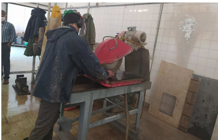
Figura 2.1 – Demonstração de um corte de material durante a vistoria
