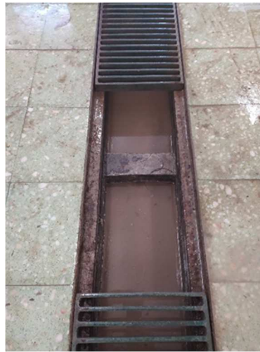
Figura 2.2 – Caleira no pavimento da sala de corte, munida de muretes para retenção de partículas
