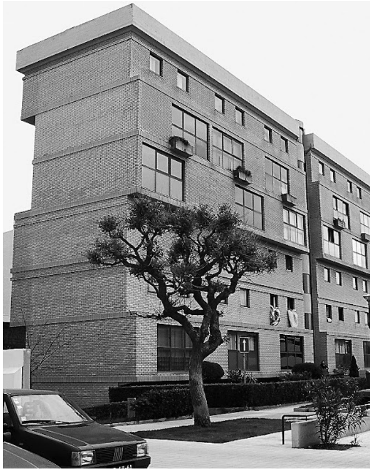
Fig. 03: grande edifício multifamiliar de preenchimento e vitalização urbana na Rua Cidade do Recife, no Viso, Porto, com 72 fogos, uma promoção da Cooperativa HABECE, arquitectos João Pestana, Chaves Almeida e Fernando Neves, 1994.
