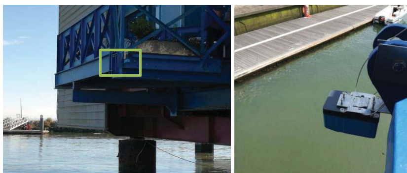
Figure 4.13 – General overview of the sensor SenZ2 installed in the Parque das Nações Marina
