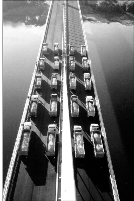
Figura 3: Comboio de cargas distribuídas.
