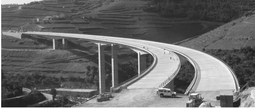
Figura 1: Vista geral da Ponte sobre o rio Corgo
