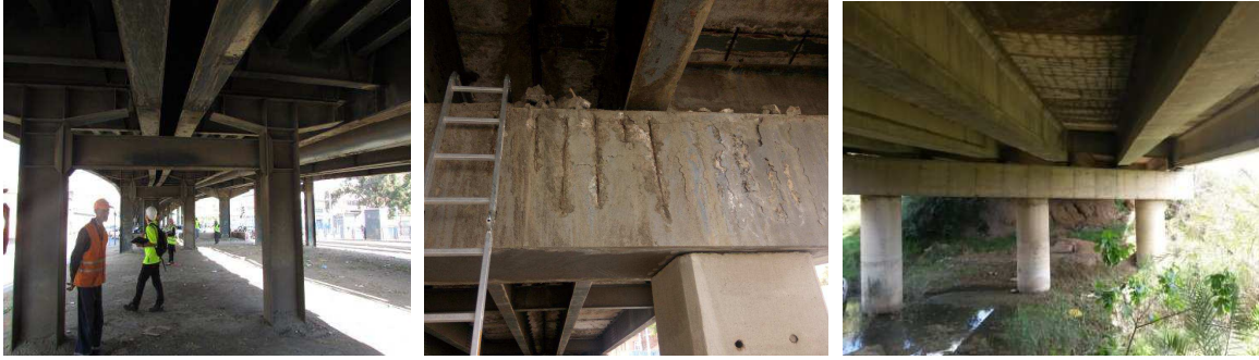
Figure 10. Inspected bridges: Viaduct El Mohammadia ; Pont de Cinq Maisons ; Pont Baraki (Macedo, A. et al. 2019)
