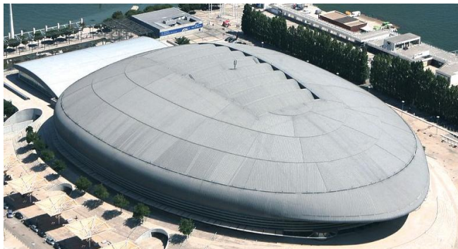
Fig. 2 MEO Arena roof
