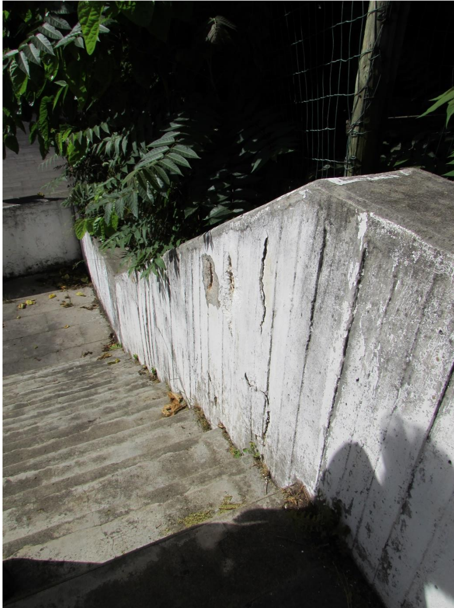
Fotografia 20 – EBI Dr. Joaquim de Barros: escadaria de ligação entre o plano superior da escola e o pátio central, e muro lateral exterior
