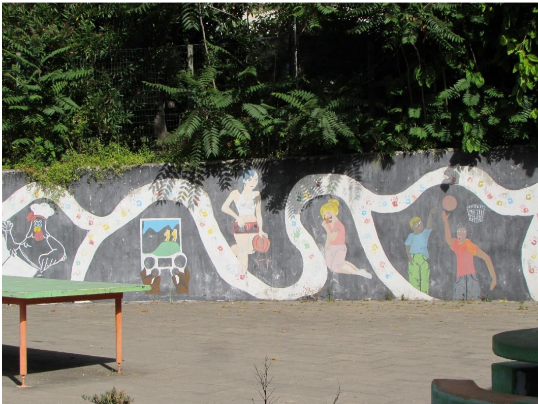
Fotografia 16 – EBI Dr. Joaquim de Barros: muro limítrofe oeste confinante com o terreno da habitação em consideração (sem sinais de deformação)
