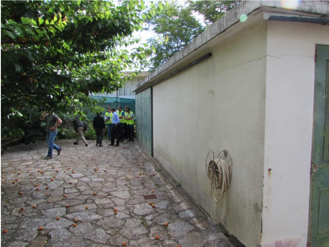
Fotografia 4 – Parede noroeste da garagem, sem danos visíveis
