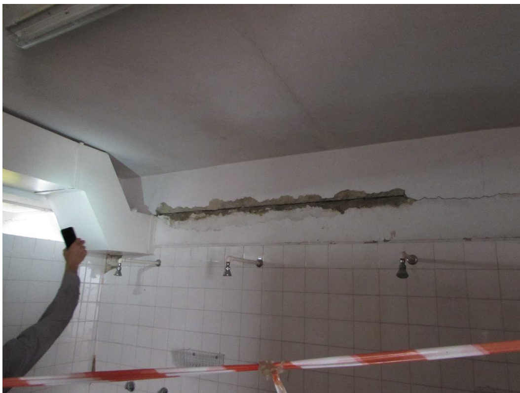
Fotografia 31 – Pavilhão desportivo: danos nas alvenarias em parede de balneário por assentamentos diferenciais
