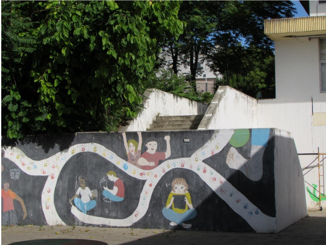
Fotografia 17 – EBI Dr. Joaquim de Barros: muro de escadaria de ligação entre o plano superior da escola e o pátio central do recreio (1 de 2)
