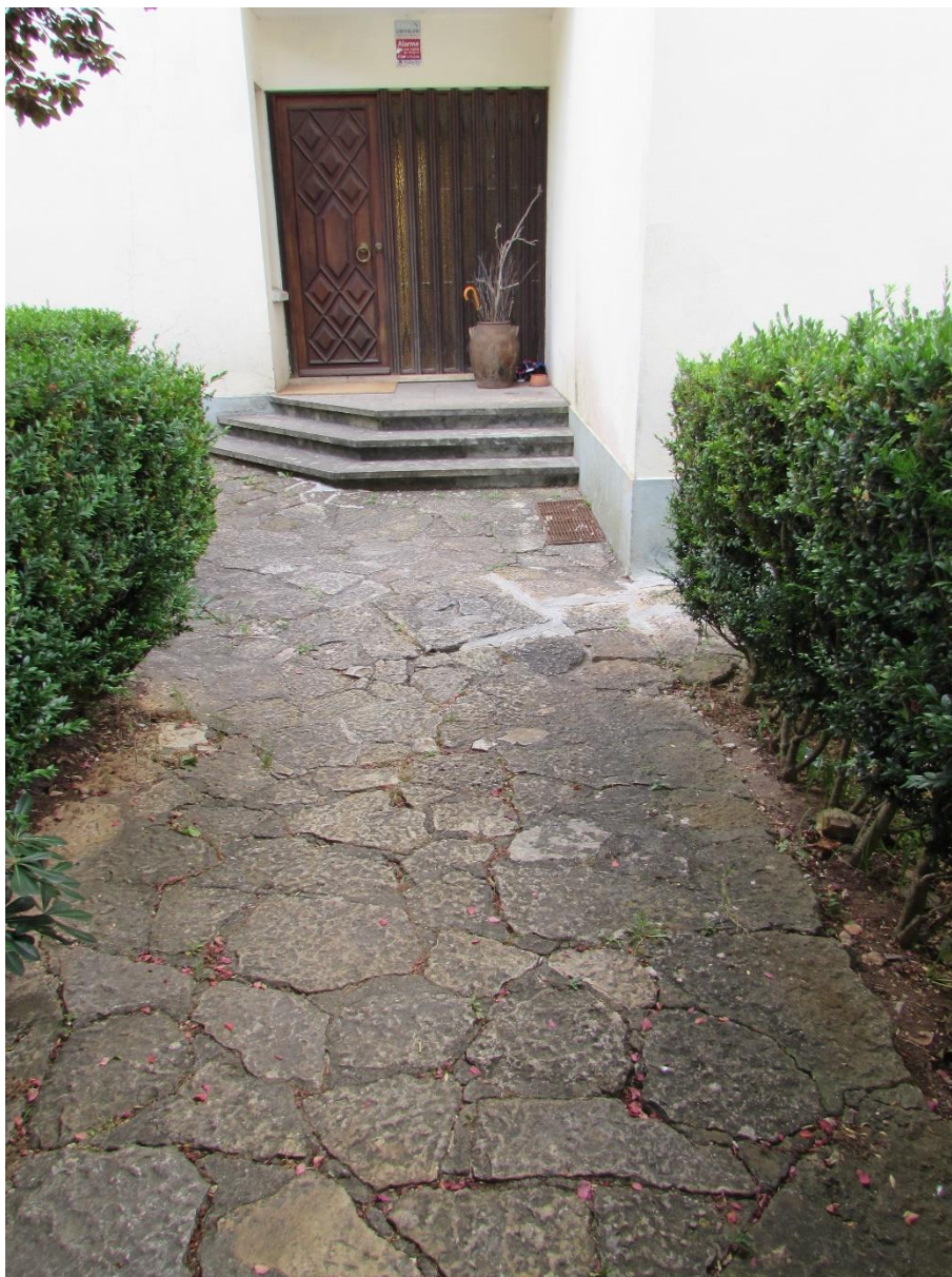
Fotografia 2 – Vista da entrada principal da habitação, sem sinais de danos por assentamento
