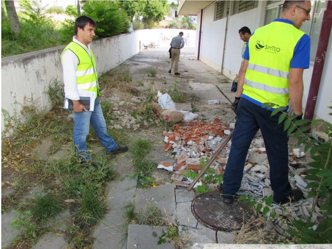
Fotografia 21 – EBI Dr. Joaquim de Barros: vereda confinante com o limite oeste do perímetro da escola; pormenor de abatimento junto a uma caixa de visita (1 de 2)
