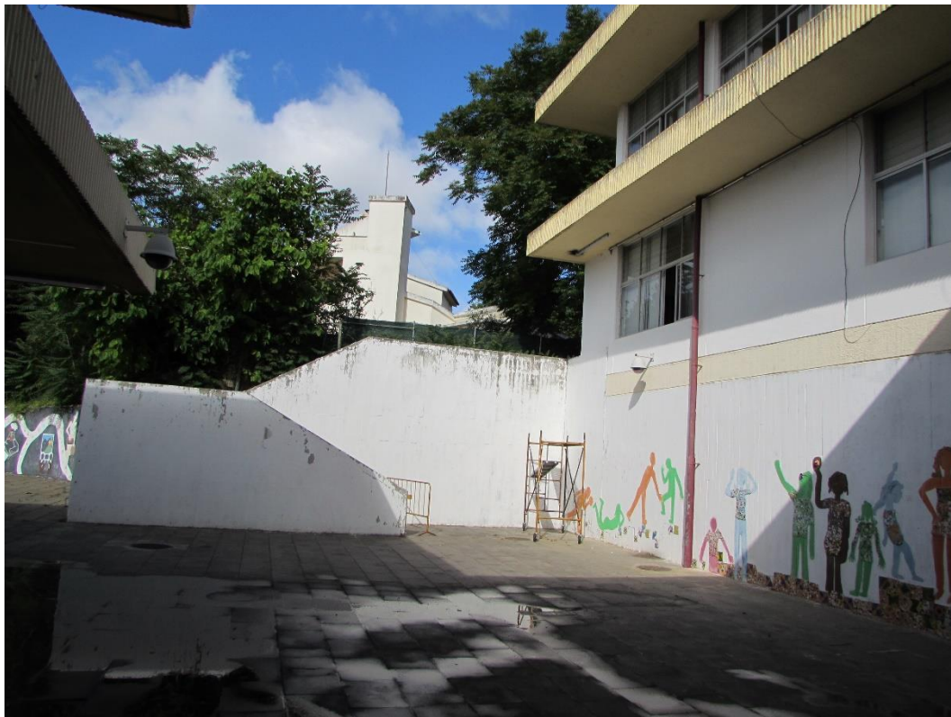
Fotografia 18 – EBI Dr. Joaquim de Barros: muro de escadaria de ligação entre o plano superior da escola e o pátio central do recreio (2 de 2)
