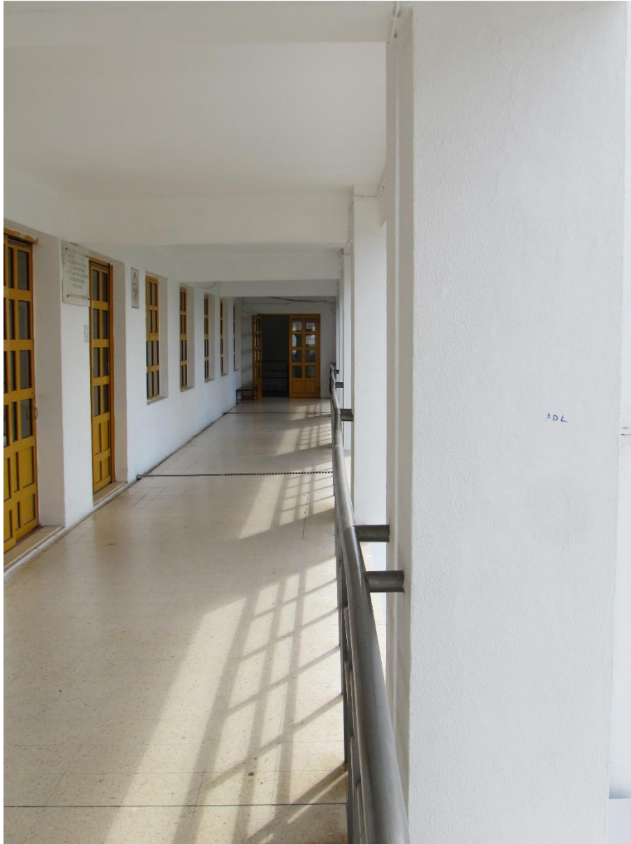
Fotografia 27 – Pavilhão desportivo: corredor de acesso à entrada principal
