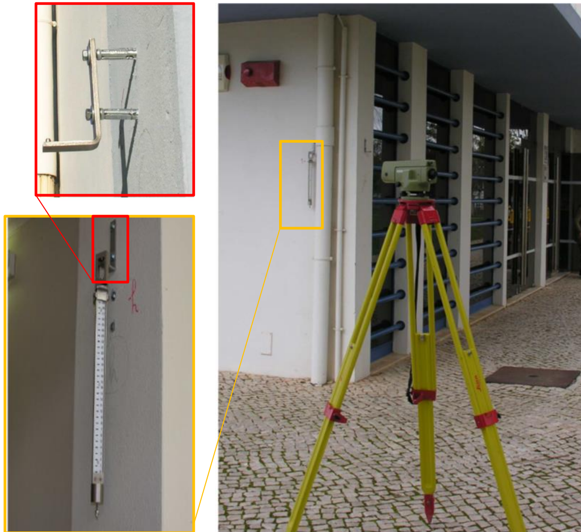
Fotografia III.1 – Vista geral e pormenores das peças para nivelamento geométrico em fachadas
