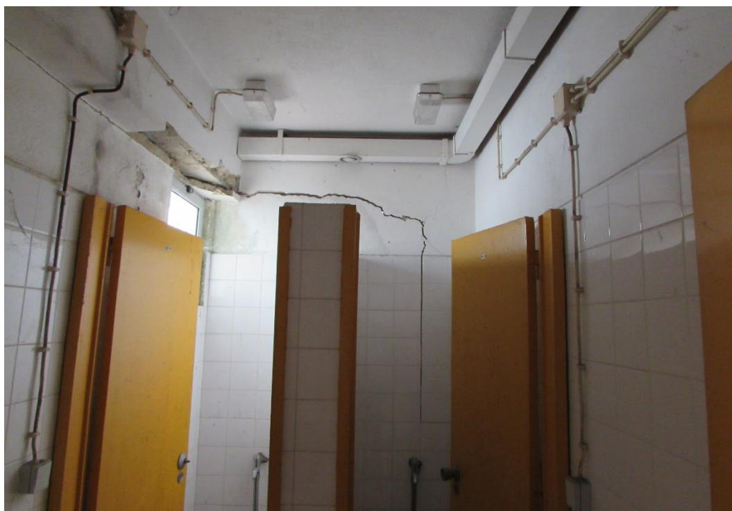
Fotografia 37 – Pavilhão desportivo: danos em alvenaria no hall do pavilhão
