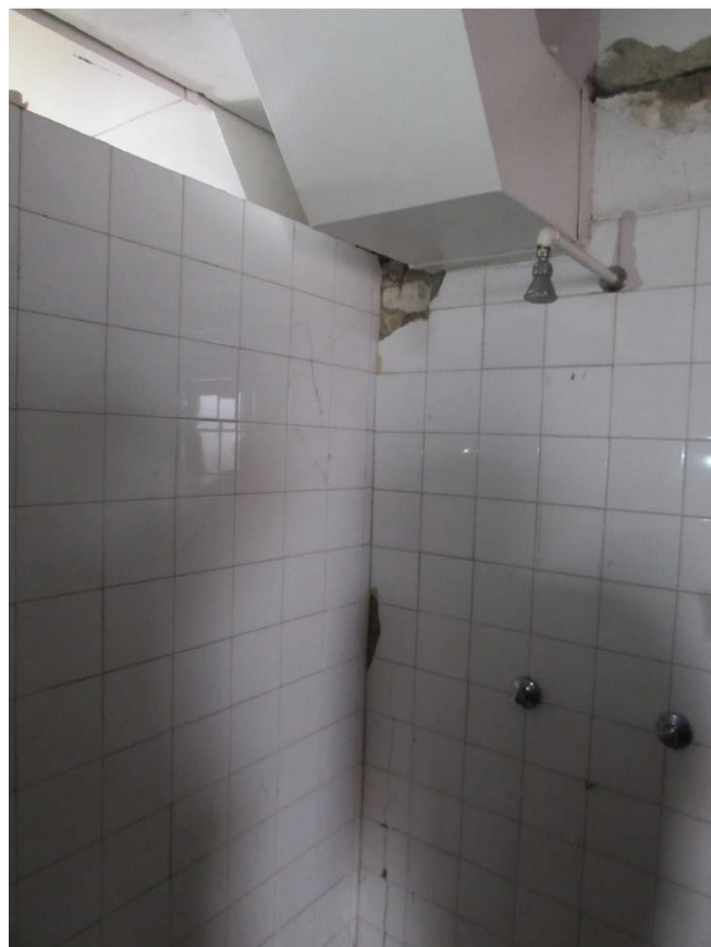
Fotografia 31 – Pavilhão desportivo: danos nas alvenarias em parede de balneário por assentamentos diferenciais
