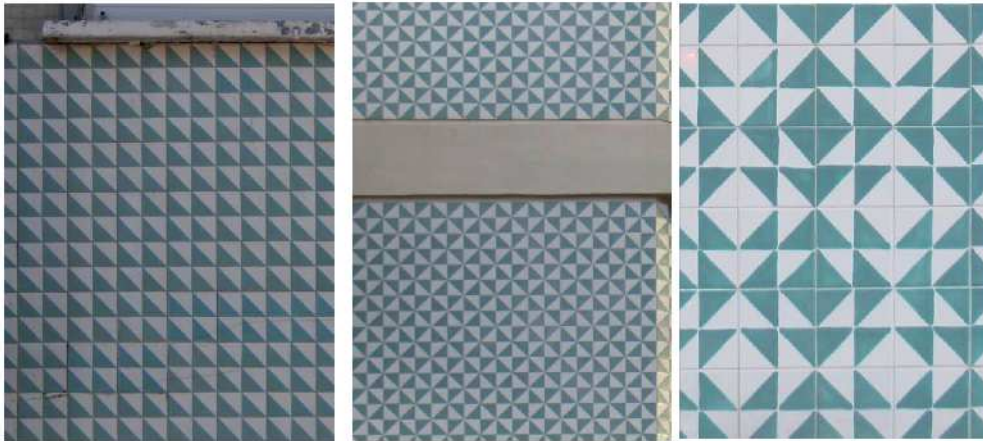
Figure 15: Three geometries of application with the same pattern. Left: R. de Júlio Dinis N° 896 ; centre: Av. da Boa Vista N° 1624 ; right: Av. da República N° 1473 (Vila Nova de Gaia)
