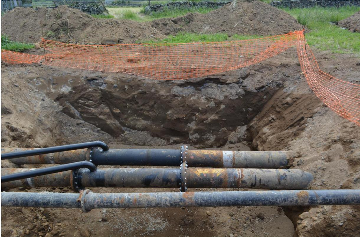
Figura 3.78 – Pormenor da ligação entre as duas linhas do *pipeline* da Cova das Cinzas e as tubagens de ventilação
