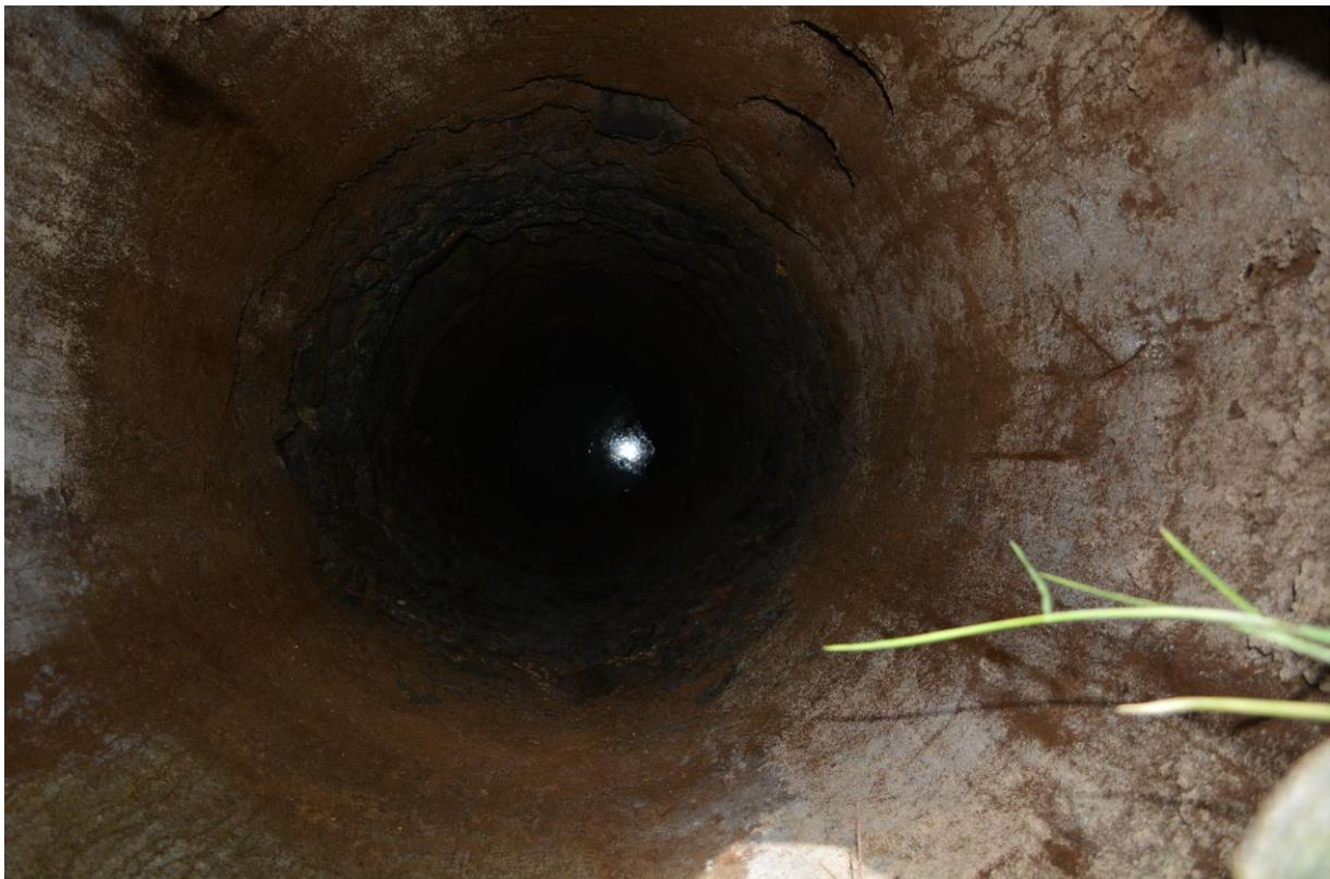
Figura 3.75 – Vista do interior do poço de água existente a NW do *pit 18* junto ao muro de pedra; nível de água a uma profundidade da ordem dos 10 m
