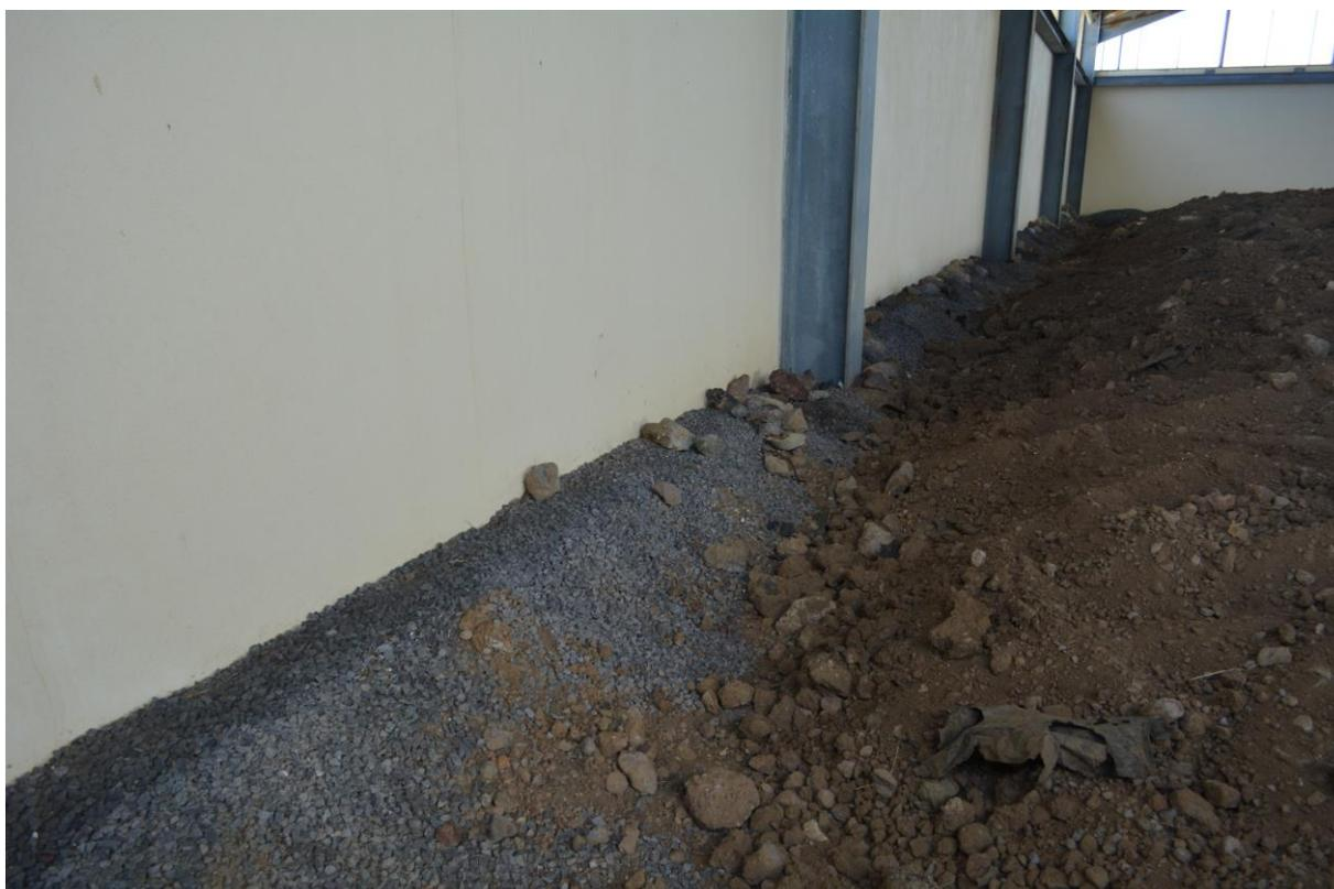
Figura 3.67 – Pormenor da camada drenante de brita colocada no pavimento da estação subjacente aos resíduos depositados
