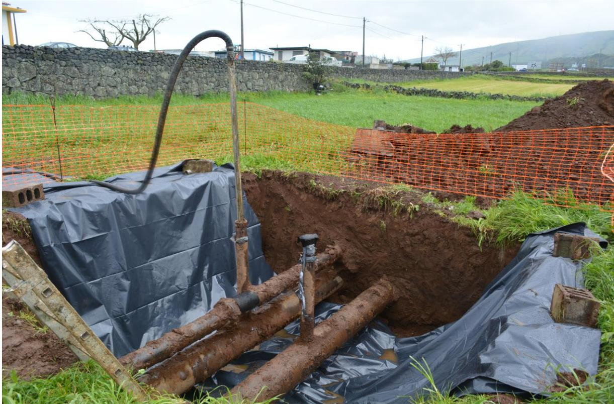
Figura 3.60 – Pormenor do dispositivo utilizado no *pit CPV3* para retirar o combustível do *pipeline*
