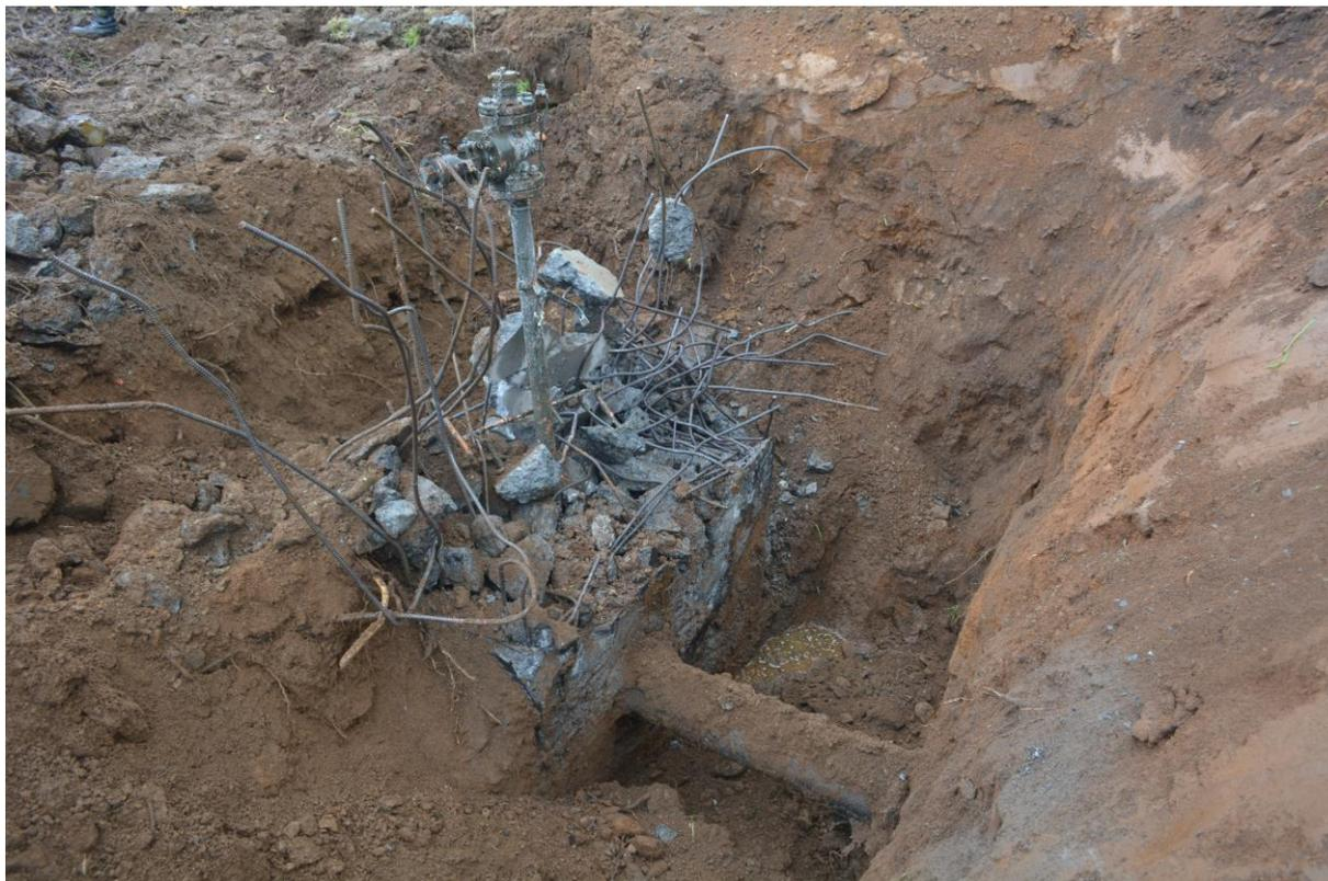
Figura 3.52 – Vista dos trabalhos de demolição realizados em *pit* existente no trecho *Cinder Pit Front 1*
