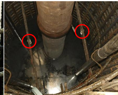
Figura 9. Extensómetros durante a betonagem de estaca
