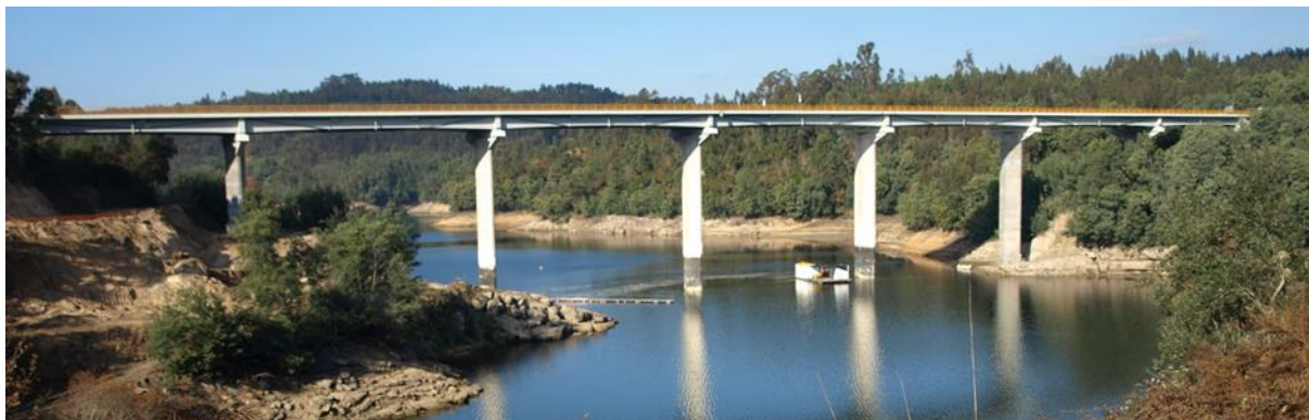
Figura 3. Ponte de São João das Areias antes da reabilitação dos pilares e fundações.
