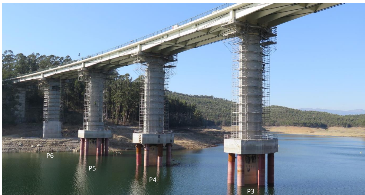
Figura 2. Ponte do Criz II no final da reabilitação dos pilares e das fundações.
