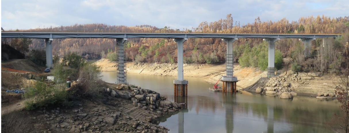
Figura 4. Vista geral da Ponte de São João das Areias no final da reabilitação dos pilares e das fundações.
