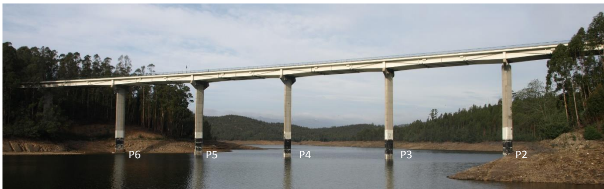
Figura 1. Ponte do Criz II antes da reabilitação dos pilares e fundações.
