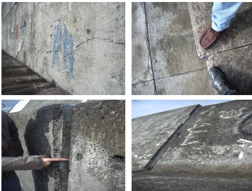
Figura 2.23 – Porto da Madalena do Pico. Fotos dos estragos provocados pelo temporal de 6 e 7 de janeiro de 2014
