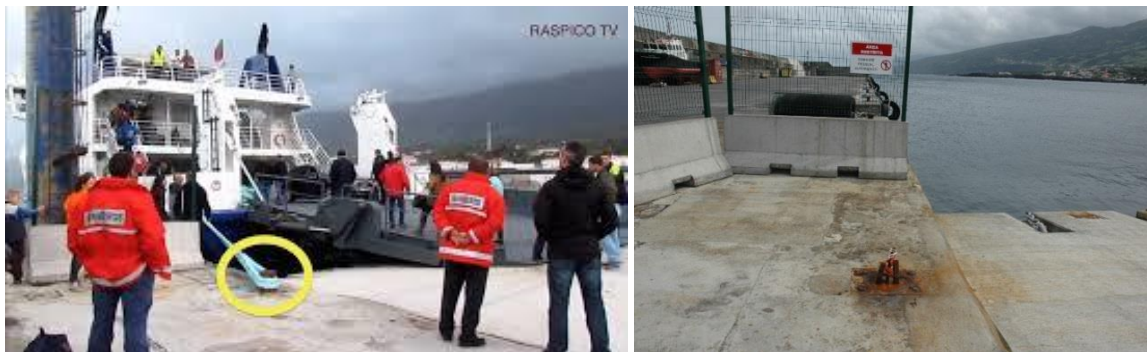
Figura 2.43 – Aspeto da atracação do ferry Gilberto Mariano ao cabeço de amarração, antes do acidente de 14 de novembro de 2014 (esq.). Aspeto da zona onde estava inserido o cabeço de amarração, após o acidente (dir.)
