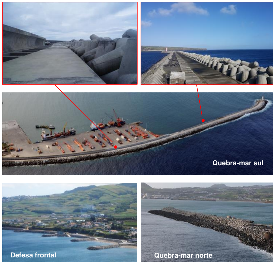
Figura 2.45 – Porto da Praia da Vitória. Principais estruturas marítimas
