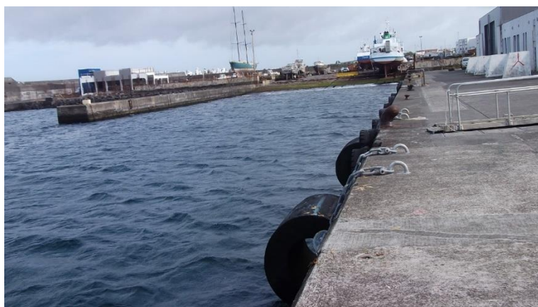
Figura 2.15 – Porto da Madalena do Pico. Rampa do porto (2015)
