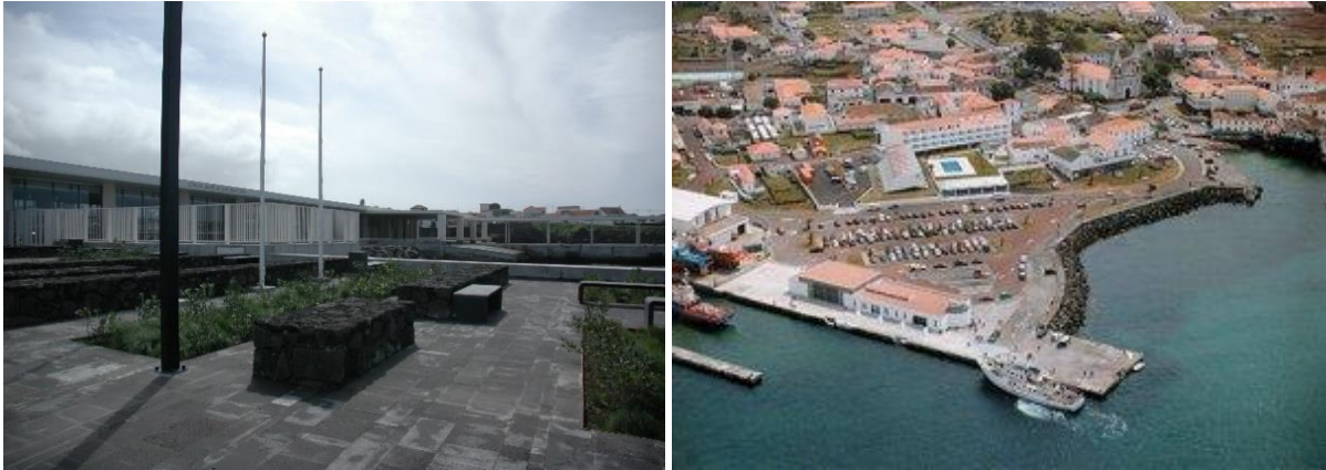
Figura 2.16 – Porto da Madalena do Pico. Novo Terminal de passageiros João Quaresma (à esq., 2015) e fotografia aérea (à dir.; portodamadalenablogspot.com)
