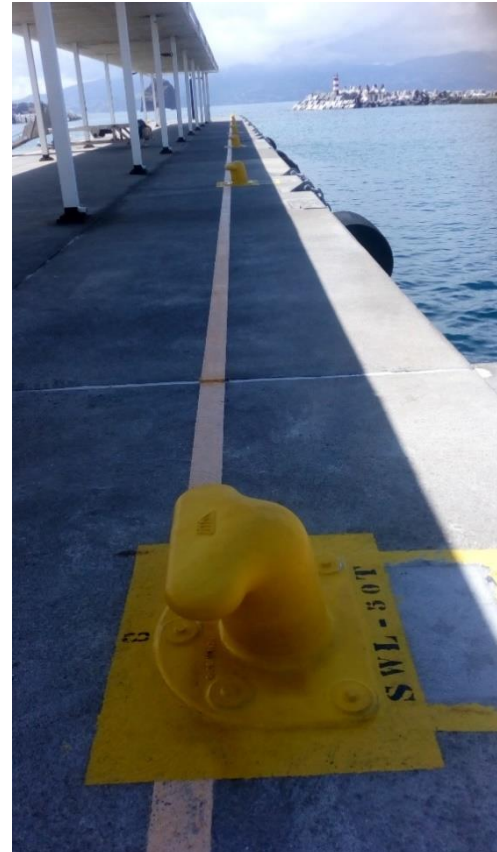
Figura 2.17 – Porto da Madalena do Pico. Zona de embarcação para navios Ro/Ro no terminal em 2015 e em 2018, com mudança dos cabeços de amarração para 50 ton
