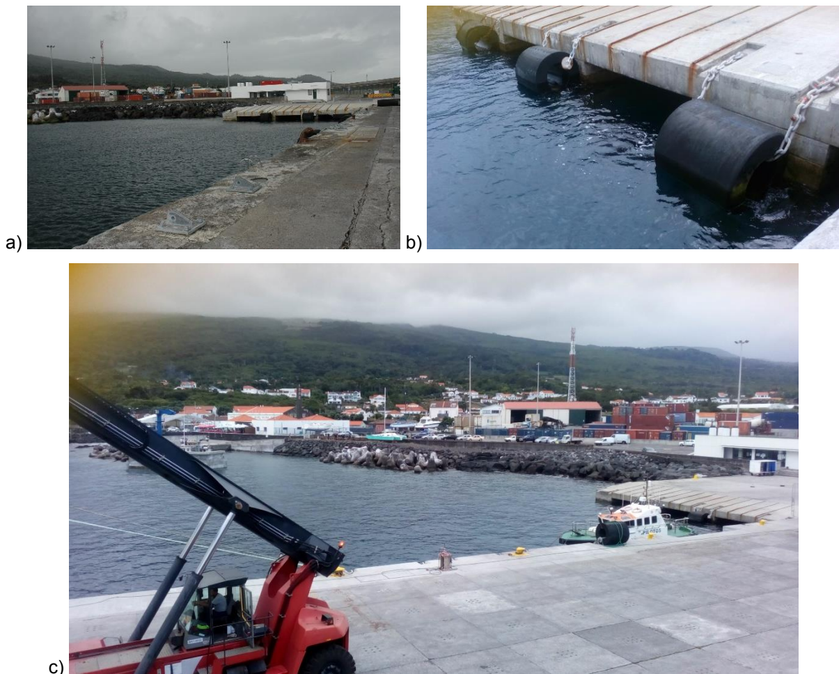
Figura 2.38 – Porto de São Roque do Pico. Foto da rampa Ro/Ro e cais ferry do porto comercial: a) 2015; b) e c) 2018
