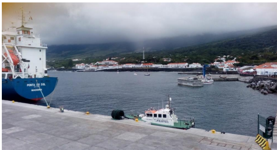
Figura 2.30 – Porto de São Roque do Pico. Zona do cais e cabeços de amarração
