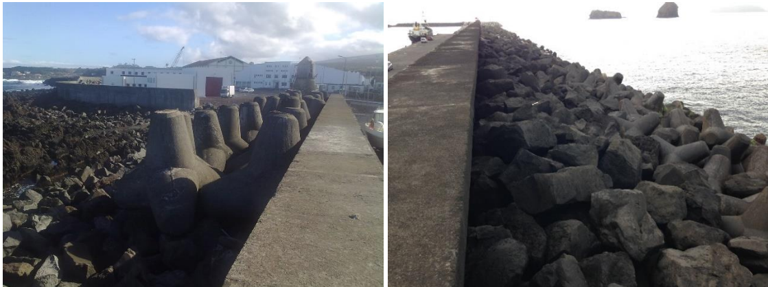
Figura 2.9 – Porto da Madalena do Pico. Tetrápodes de reserva (esq.); Vista do quebra-mar norte exterior (2015) (dir.)
