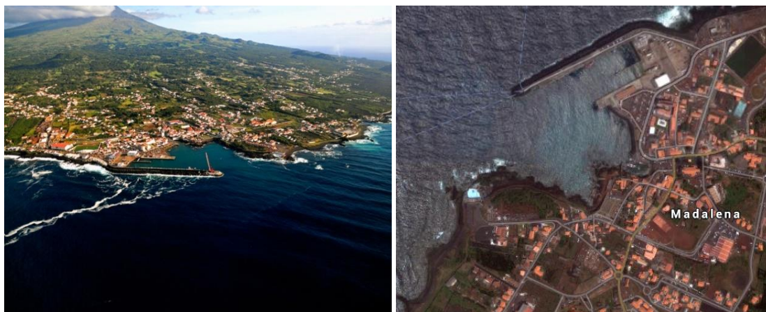
Figura 2.2 – Porto da Madalena do Pico. Fotografia aérea da vila de Madalena; Porto da Madalena – Google Earth© 2011
