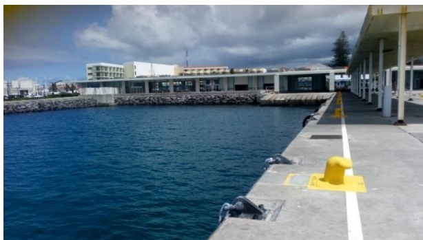
Figura 2.17 – Porto da Madalena do Pico. Zona de embarcação para navios Ro/Ro no terminal em 2015 e em 2018, com mudança dos cabeços de amarração para 50 ton
