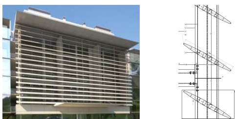
Figura 1 – Dispositivo de sombreamento e esquema de montagem.
