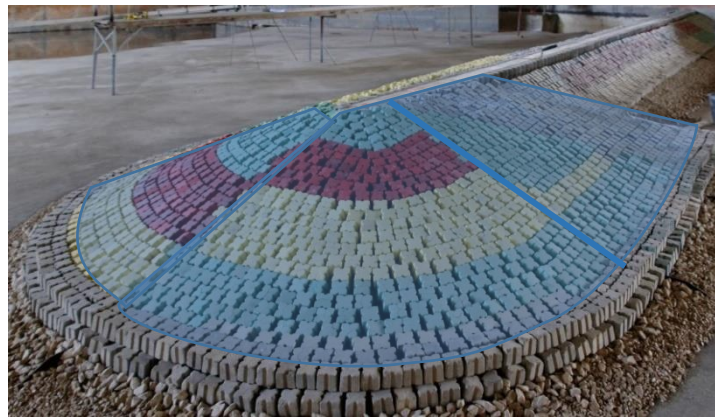
Figura 18 - Troços G, H e I. Aumento da densidade de colocação nas zonas de maior ocorrência de movimentos e aumento do peso dos blocos do pé do talude.
