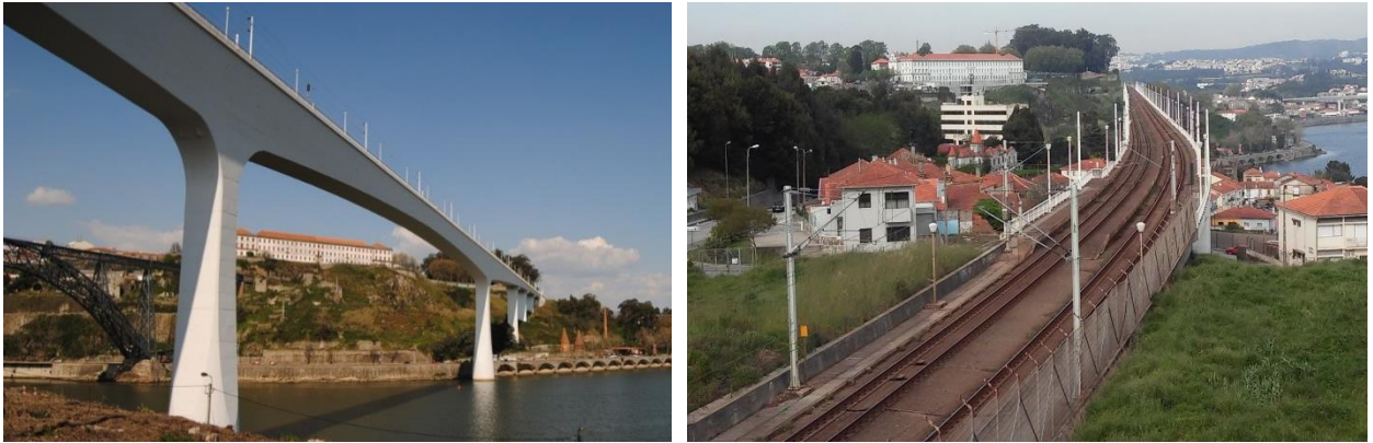
Fig. 1. São João Bridge
