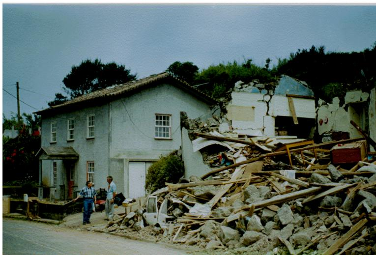
*Figura 2.9 – Contraste entre uma construção reforçada (esquerda) e o colapso total da construção vizinha (direita), Espalhafatos - Faial.*
