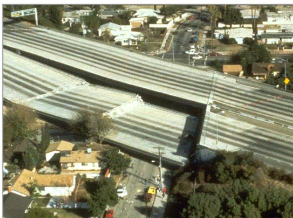
Figura 2.6 – Rotura de pilares na ponte Mission and Gothic, em Northridge [USGS, 2001b].
