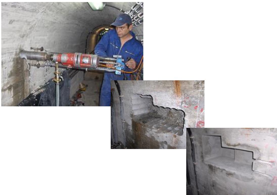
Figura 3.9 – Trabalhos de abertura de nichos para colocação dos acelerómetros
