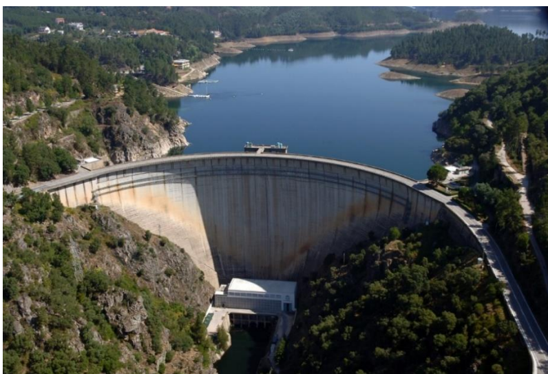
Figura 1.1 – Barragem do Cabril (rio Zêzere). Vista de jusante
