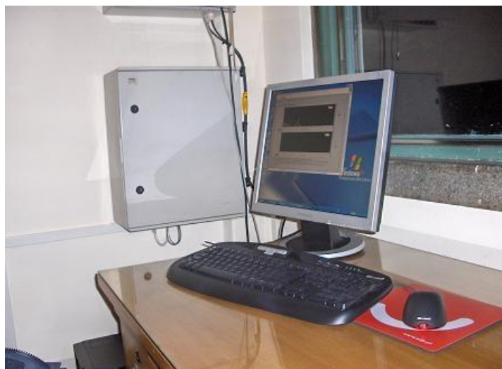
Figura 3.11 – Servidor no Gabinete de observação da barragem do Cabril, onde é efectuado o controlo do sistema e o armazenamento dos dados, nos escritórios da central da barragem
