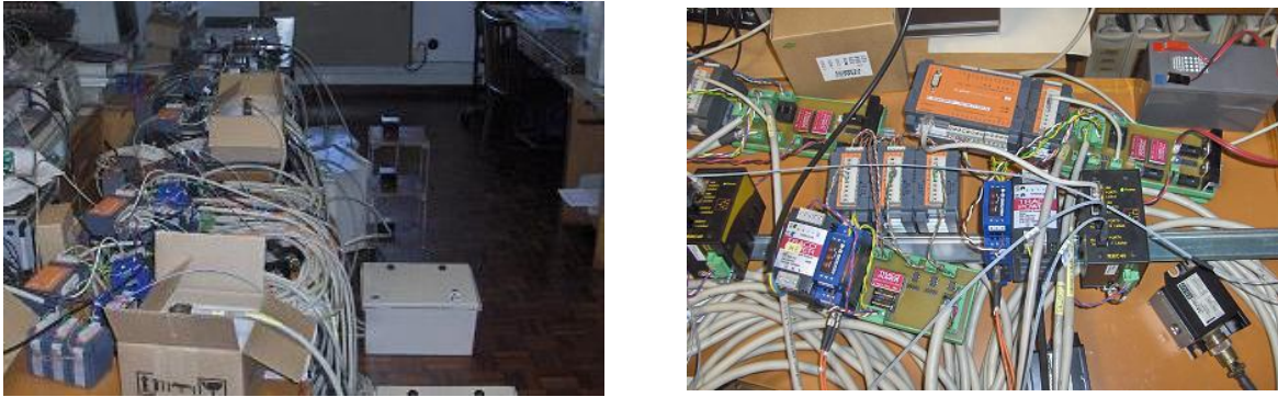
Figura 3.7 – Equipamento em fase de testes no laboratório de eletrónica no LNEC/CIC
