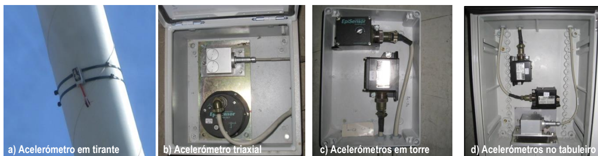
Figura 7. Medição de acelerações nos tirantes, torres e tabuleiro
