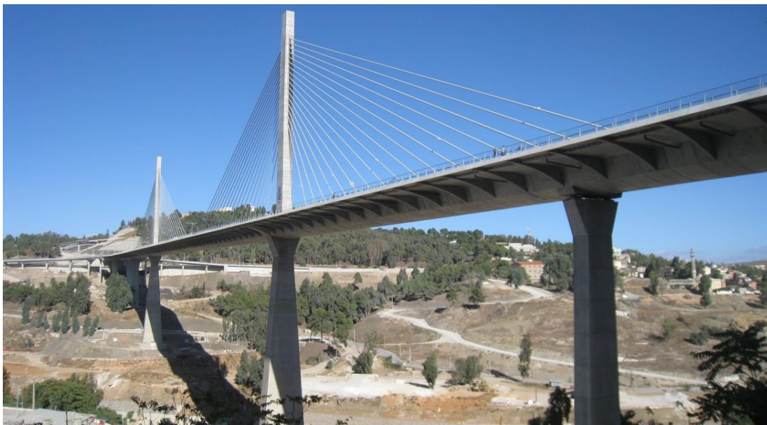
Figura 1. Vista geral do Viaduto Salah Bey
