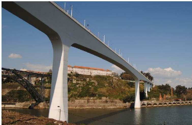
Figura 1. Vista geral da ponte de S. João
