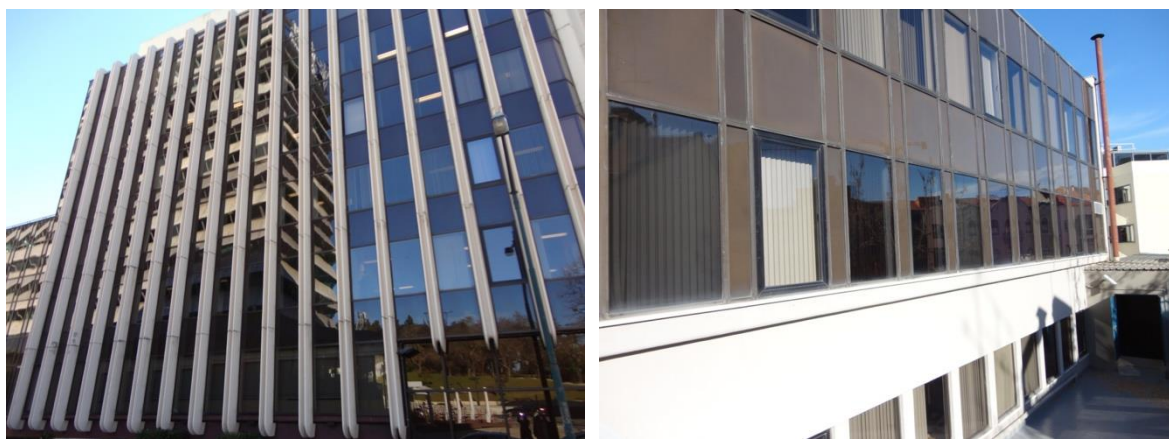
Figura 1: Vistas das fachadas principal e de tardoz do edifício estudado
