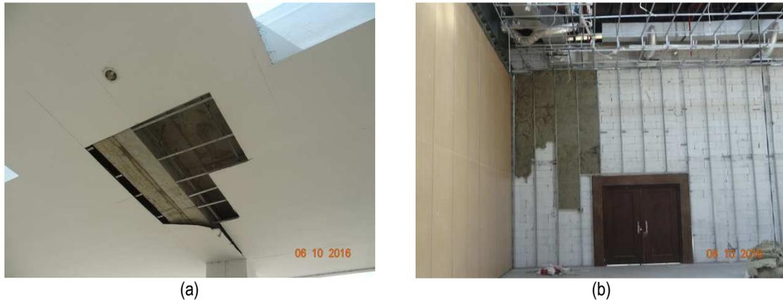
Figura 2.11 – Ministério das Finanças – Vista de um teto falso em placas de gesso cartonado (a) e duma parede de alvenaria de blocos de betão leve (b)
