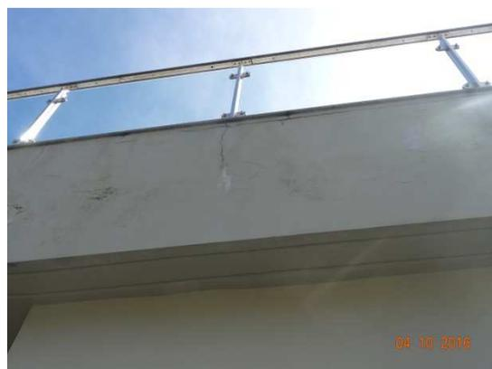
Figura 2.5 – Fissuração localizada numa platibanda
