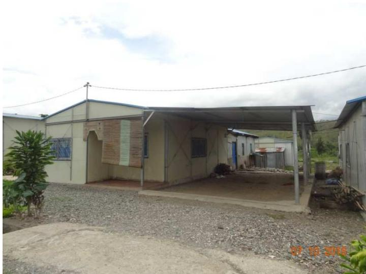
Figura 2.17 – Casas do Programa MDG – Proteção solar dos envidraçados com esteira de bambu
