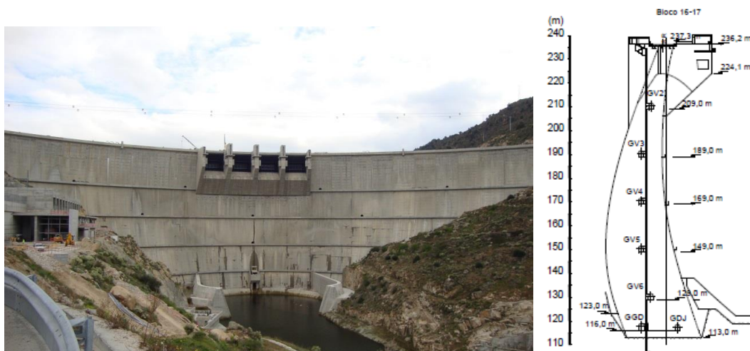
Fig. 4 - Vista de jusante da barragem do Baixo Sabor e corte vertical pela consola central
