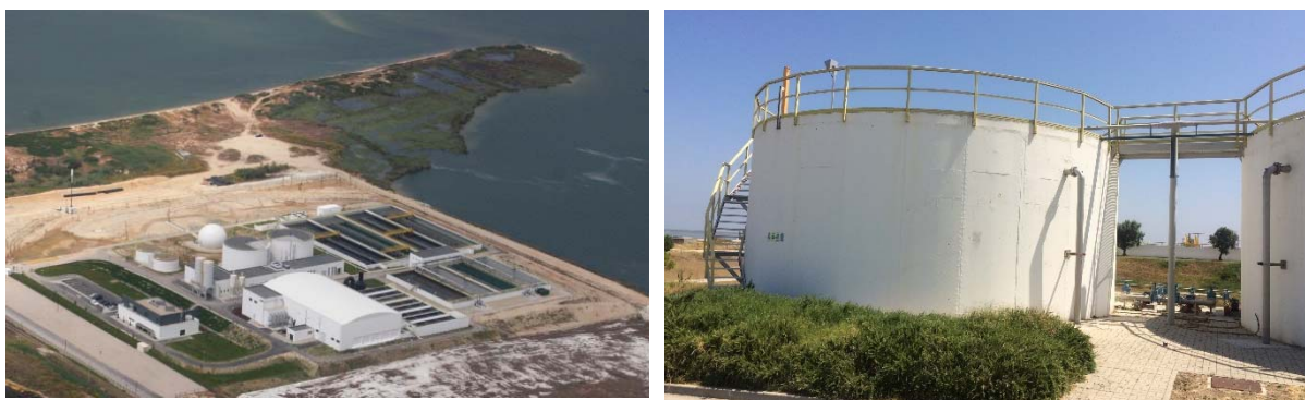
Figura 5: Vista aérea da ETAR do Barreiro (à esquerda, AdP; 2015); uma das subestruturas exteriores inspeccionadas (à direita).
