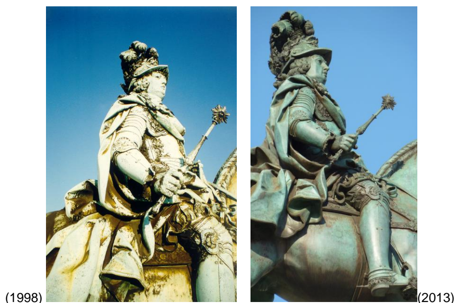
Figura 3: Estátua equestre de D. José I (1775), Lisboa. Aspeto da superfície antes (em 1998) e após os trabalhos de conservação (em 2013)
