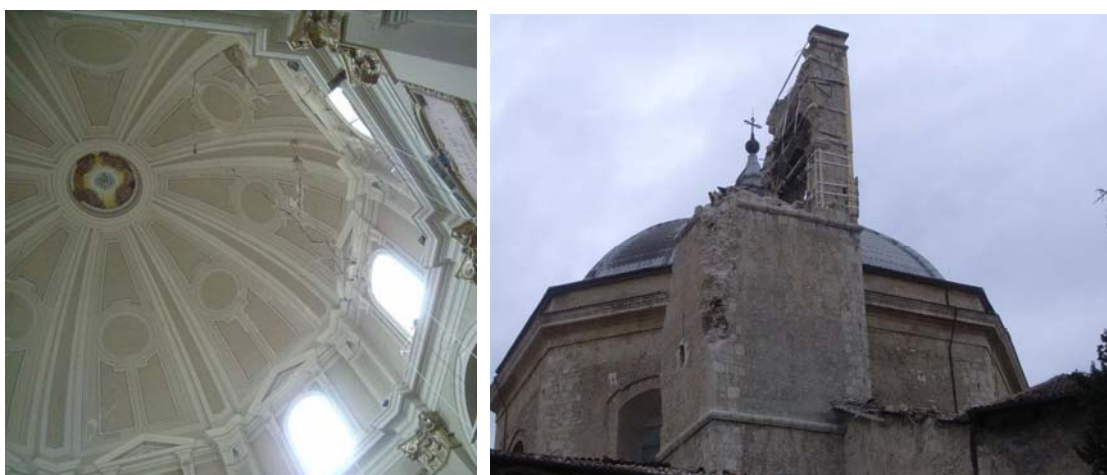
Figura 4. Activação de um mecanismo de colapso de uma cúpula (Mec.14, esquerda) e derrube de torre sineira (Mec.27, direita) de duas igrejas em L'Aquila
