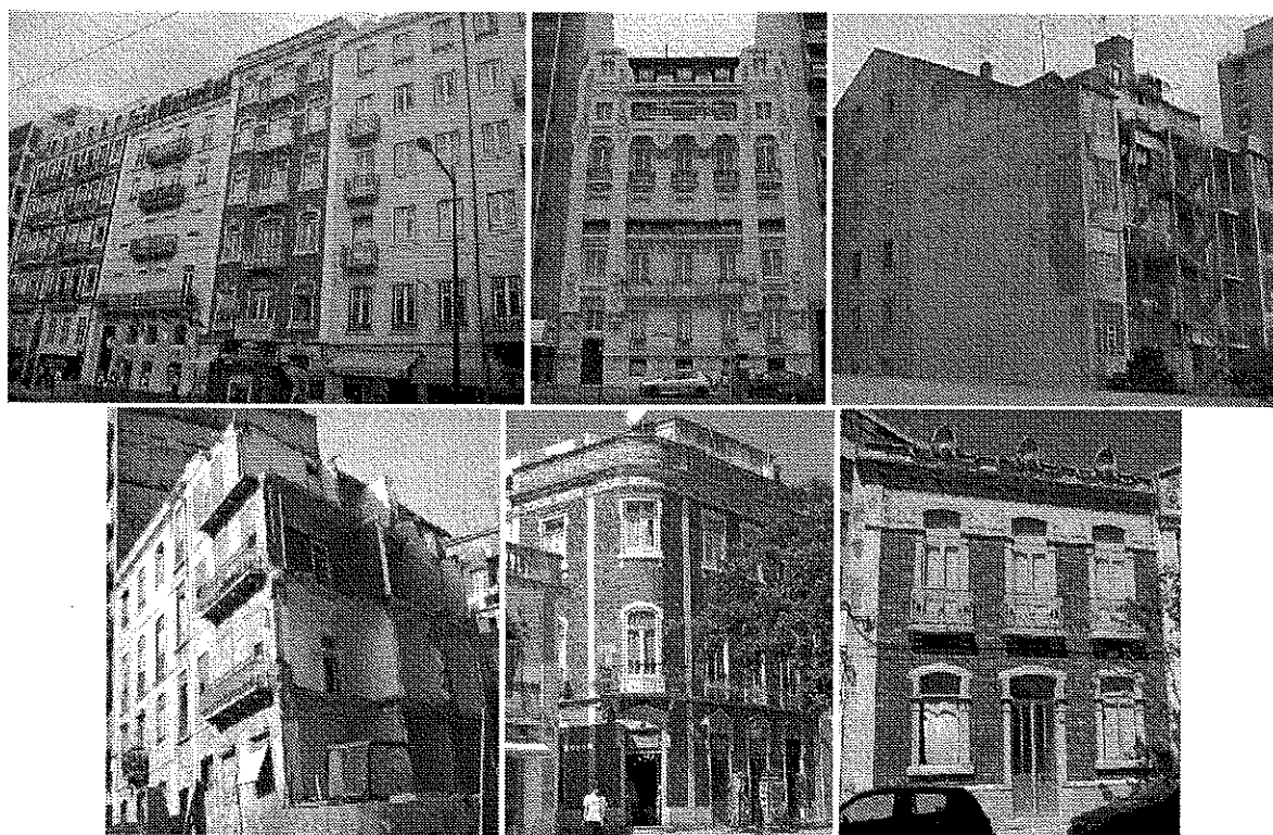
Fig. 9 – Exemplos de edifícios gaioleiros; em cima: fachadas e tardo de gaioleiros localizados em Lisboa; em baixo: interior de gaioleiro em Lisboa e fachadas em Lagos e na Figueira da Foz; classificados nos Censos 2001 como ASP
