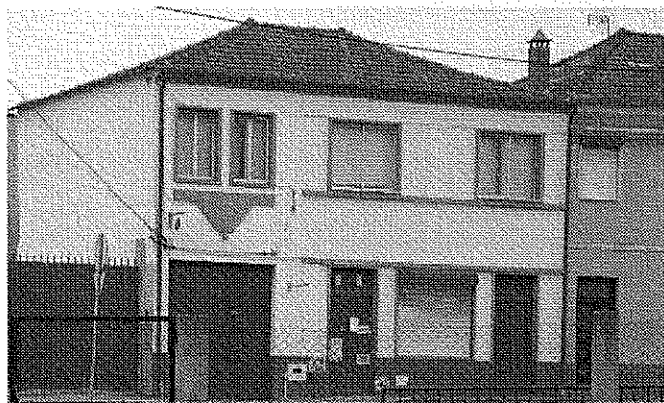
Fig. 12 – Exemplo de edifícios de pequeno porte de alvenaria confinada no concelho de Anadia; classificados nos Censos 2001 como ACP com 2 pavimentos; esquerda: edifício da época 1945-60 ou 1961-70; direita: edifício posterior a 2001
