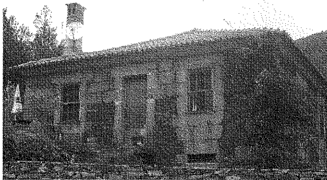
Fig. 4 – Exemplo e pormenor de edifício de habitação no concelho de Manteigas com paredes em granito e xisto argamassadas com barro vermelho; classificado nos Censos 2001 como ASP, anterior a 1919, de 2 pavimentos
