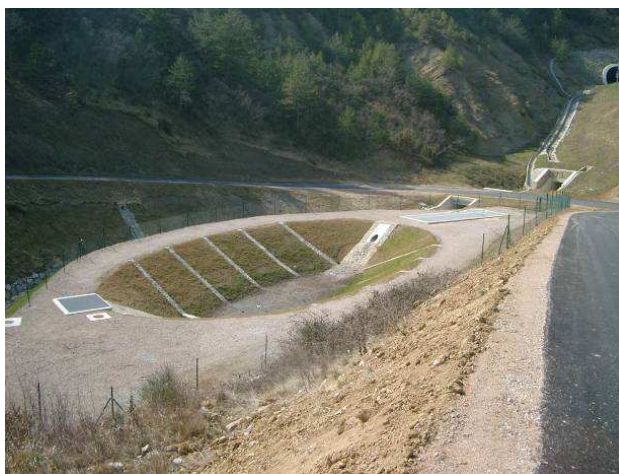
Fig. 31 - Bacia de tratamento à saída de uma zona cársica da Eslovénia (cortesia de M. Brenčič)
