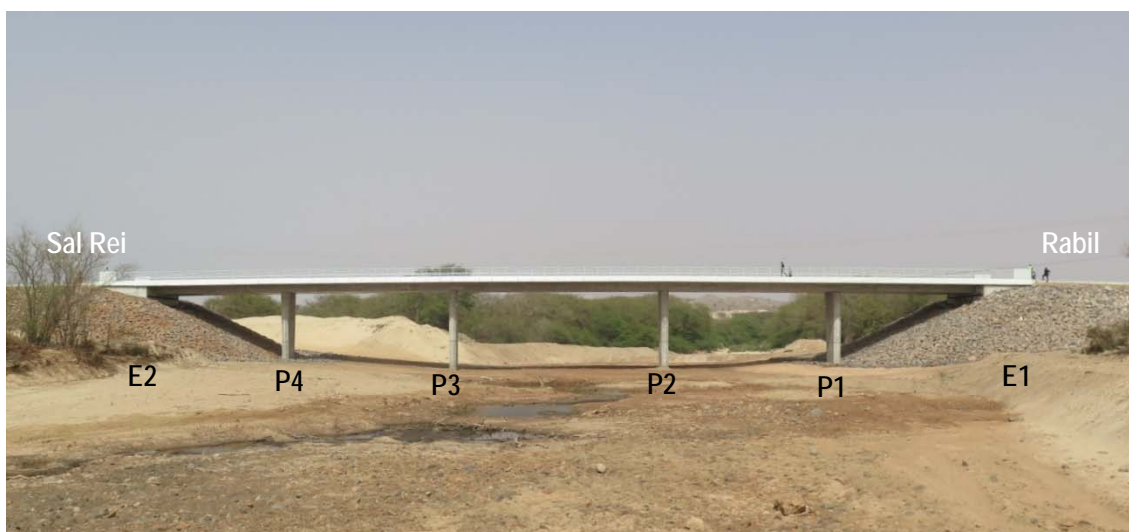
Figura 1. Vista de jusante da ponte.
