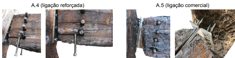
Figura 8. Ligações A.4 e A.5 após os ensaios de resistência ao fogo.
