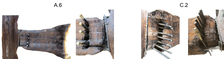
Figura 11. Ligações A.6 e C.2 após os ensaios de resistência ao fogo.
