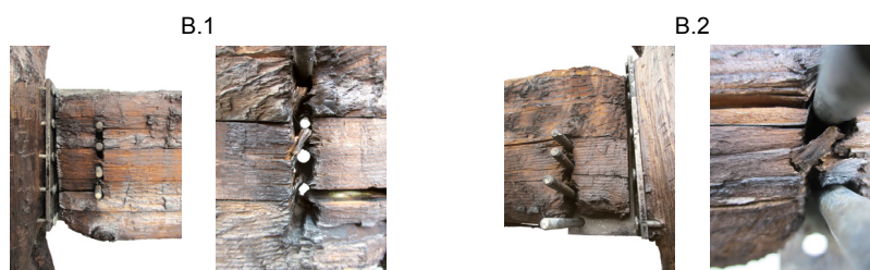
Figura 9. Ligações B.1 e B.2 após os ensaios de resistência ao fogo.
