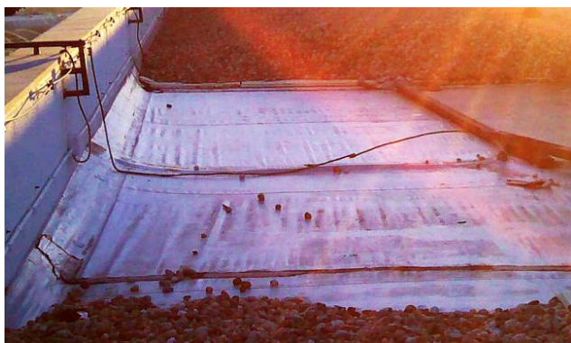
Figura 2.6 – Fotografia da membrana de impermeabilização da cobertura do edifício da empresa Municipalia.
