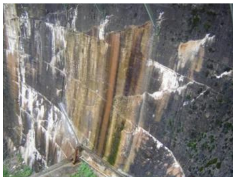
Figura 4.29 – Fendas e deposição de carbonatos no paramento de jusante (margens esquerda e direita, respetivamente) da barragem do Alto Ceira.
