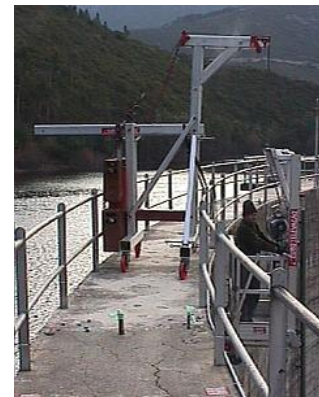
Figura 4.36 – Estrutura de suporte do bailéu instalada no coroamento.
