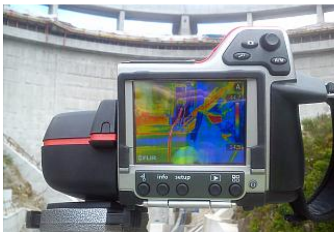
Figura 4.6 – Imagem termográfica da zona inferior da barragem.
