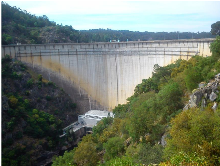
Figura 4.44 – Fotografia da barragem do Cabril tirada no mesmo período e no mesmo local de onde foi realizado o levantamento térmico.
