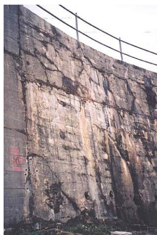
Figura 4.29 – Fendas e deposição de carbonatos no paramento de jusante (margens esquerda e direita, respetivamente) da barragem do Alto Ceira.
