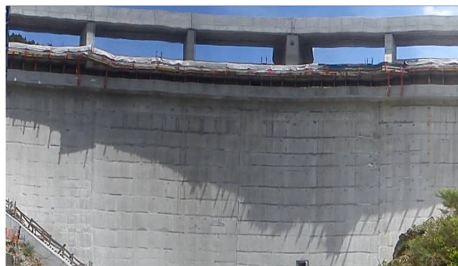
Figura 4.20 – Sombras no paramento de jusante na imagem obtida às 13h13min, onde se vêem as sombras provocadas por elementos de apoio à construção.
