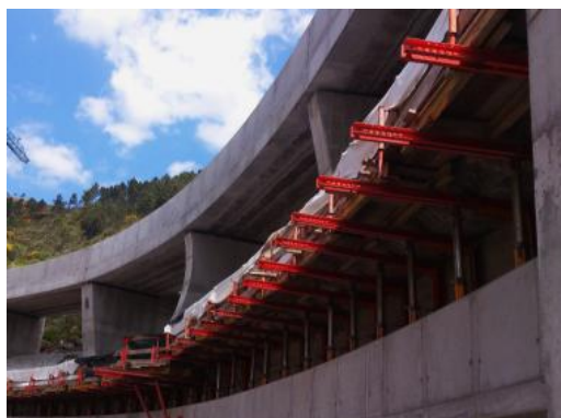
Figura 4.19 – Elementos de apoio à construção que estão na origem das diferenças de temperatura assinaladas a azul na Figura 4.18.
