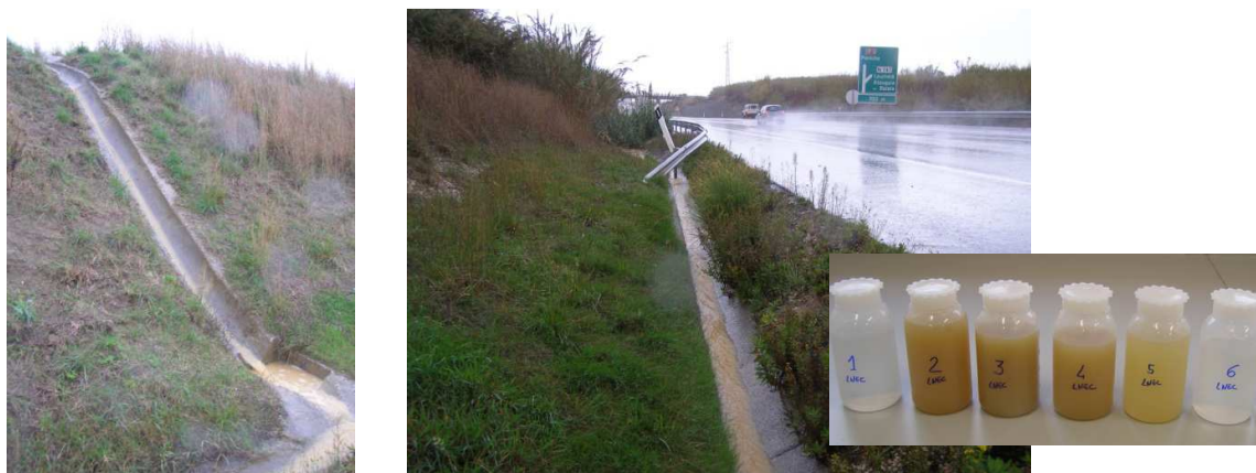
Figura 1 – Drenagem rodoviária: o transporte de águas pluviais de taludes e do pavimento, traduzindo a incorporação de diferentes substâncias. Amostras de águas de escorrência rodoviária e do meio hídrico receptor das mesmas, sendo visível o efeito de diluição no aspeto da água.
