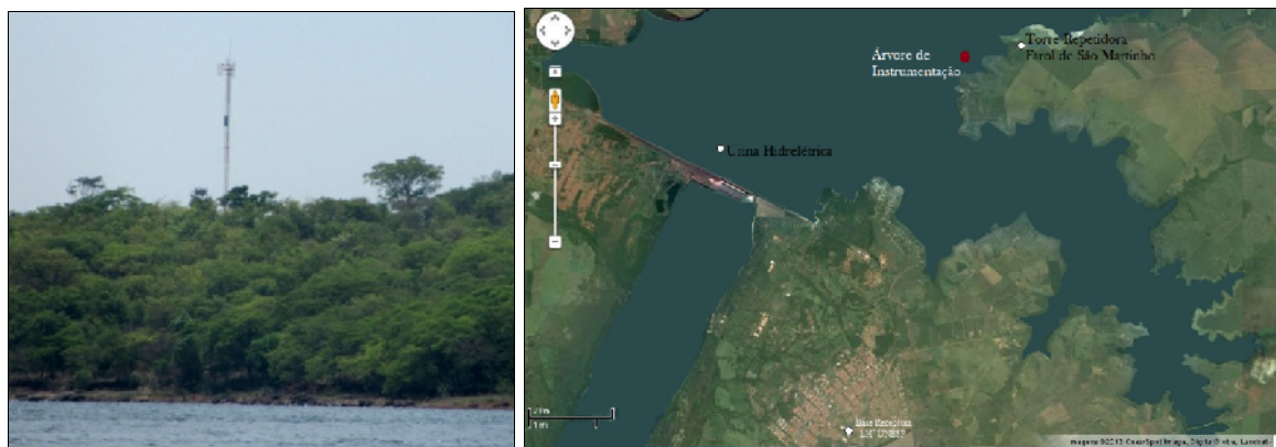
Figura 3. Torre repetidora no Farol de São Martinho. Localização da torre de instrumentação, repetidora e receptora.
