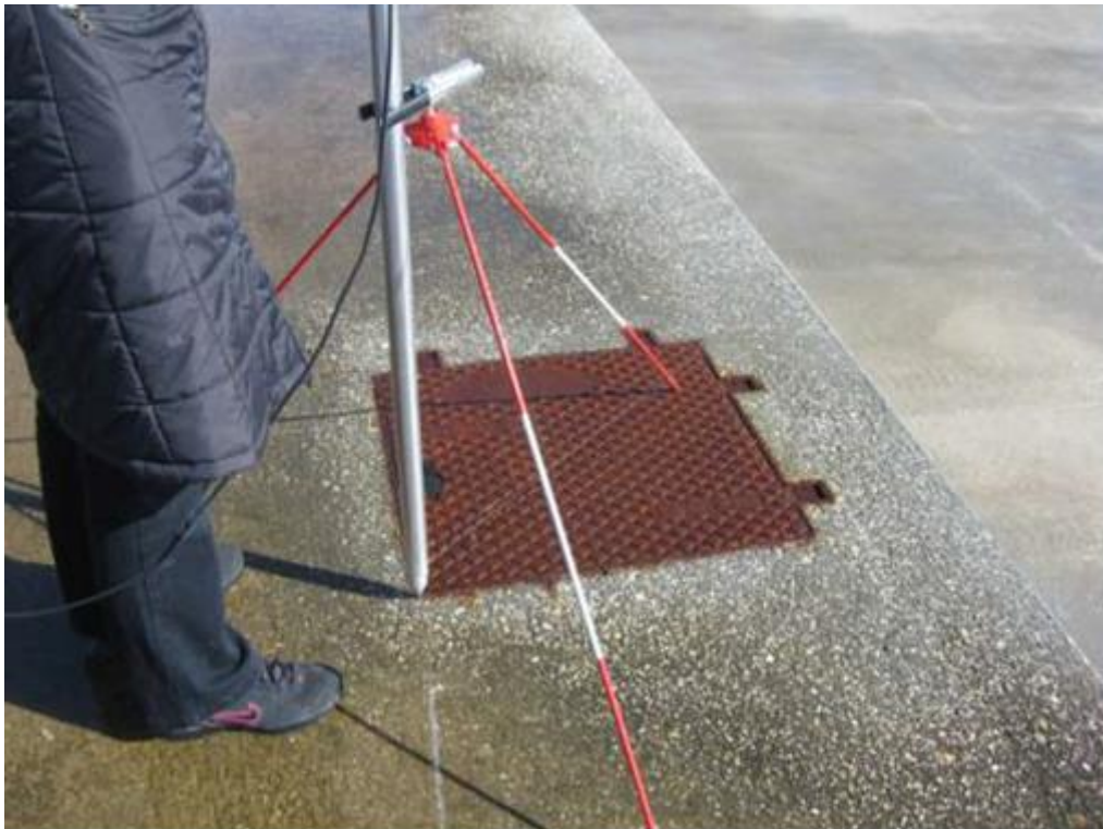
Figura 2.5 – Coordenação com GNSS de pontos de controlo
