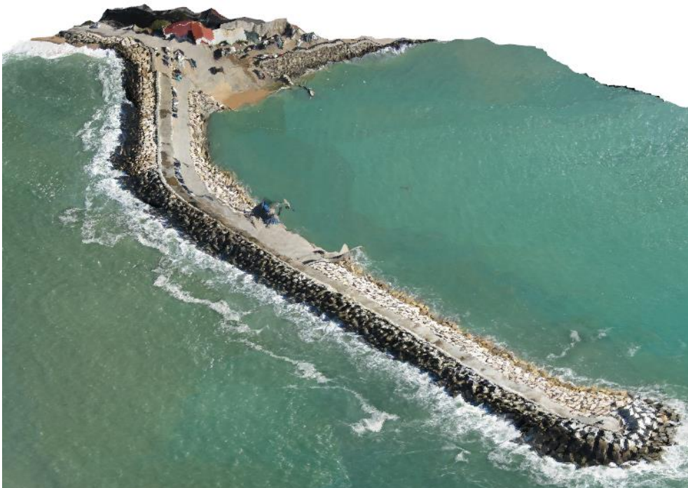
Figura 3.7 – Modelo tridimensional do quebra-mar
