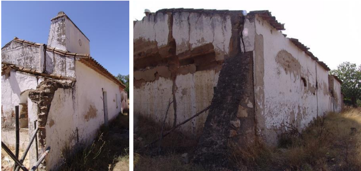
Figura 4.3. Edificação do Monte das Covas, Avis: à esquerda, fachada sudeste e nordeste; à direita, fachada noroeste com um contraforte de pedra e fachada sudoeste
