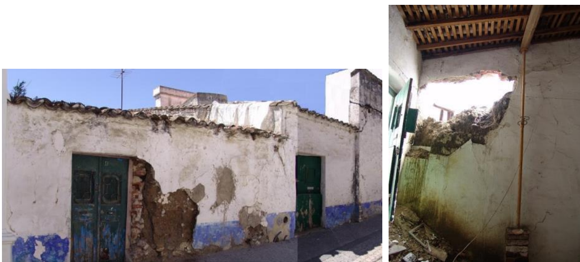
Figura 4.10. Edificação em Arraiolos: à esquerda, fachada principal (norte); à direita, empena do alçado este degradado
