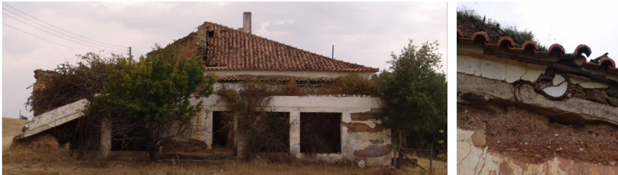
Figura 73.A. À esquerda, alçado lateral direito (sudeste), e à direita, pormenor de viga de bordadura e tirante
