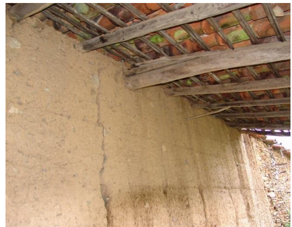
Figura 80. À esquerda, zona do telheiro, e à direita, pormenor da entrega da estrutura de cobertura na parede de taipa e visualização de uma fenda vertical
