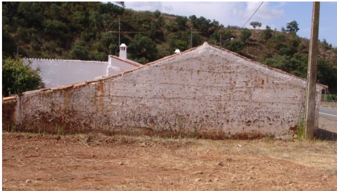
Figura 14.A. À esquerda, alçado lateral esquerdo (nordeste) com o revestimento bastante erodido, e à direita, alçado posterior (sudeste)
