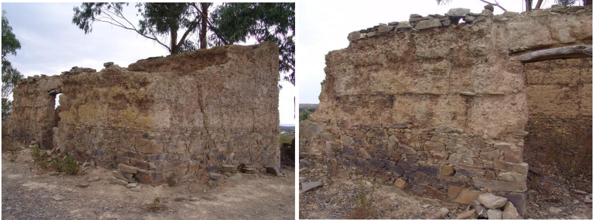
Figura 75.A. À esquerda, alçados principal (sueste) e lateral direito, e à direita pormenor da parede de taipa e embasamento
