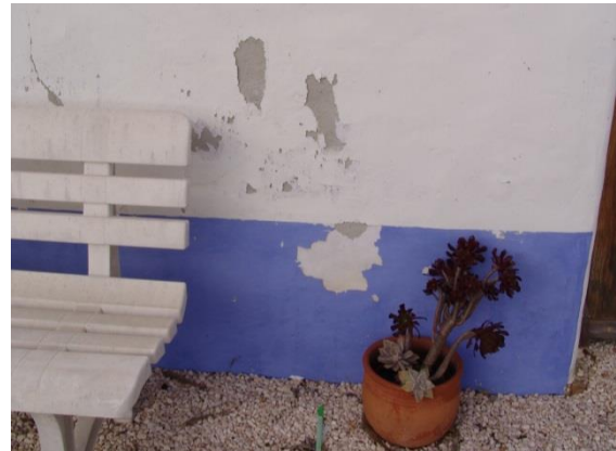
Figura 40.A. À esquerda, alçado posterior, e à direita, detalhe de humidade (devido a humidades ascensionais)
