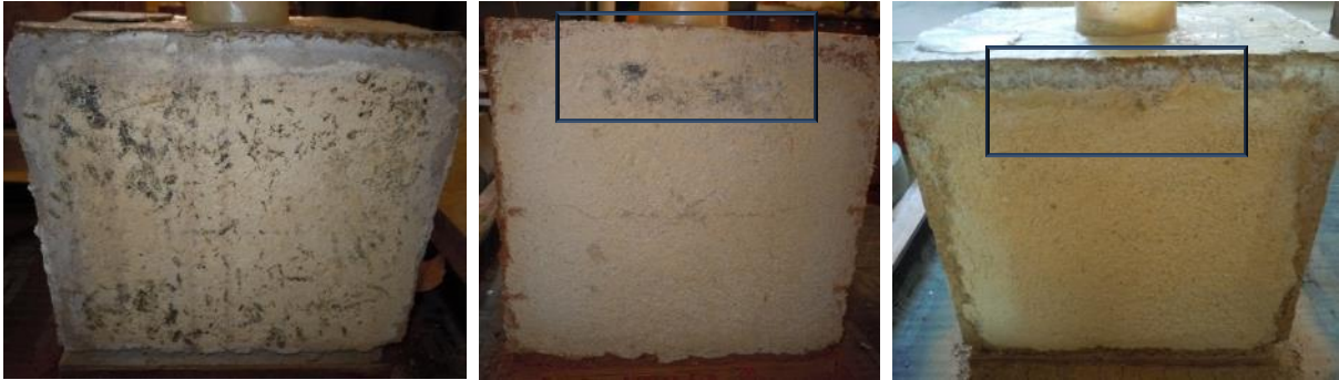
Figura 7.38. Fungos/bolores na argamassa ATP_CA_Fib, 60 dias após ter terminada a fase de absorção de água a partir do topo: à esquerda, BAv; ao centro, BPD; à direita, BVC
