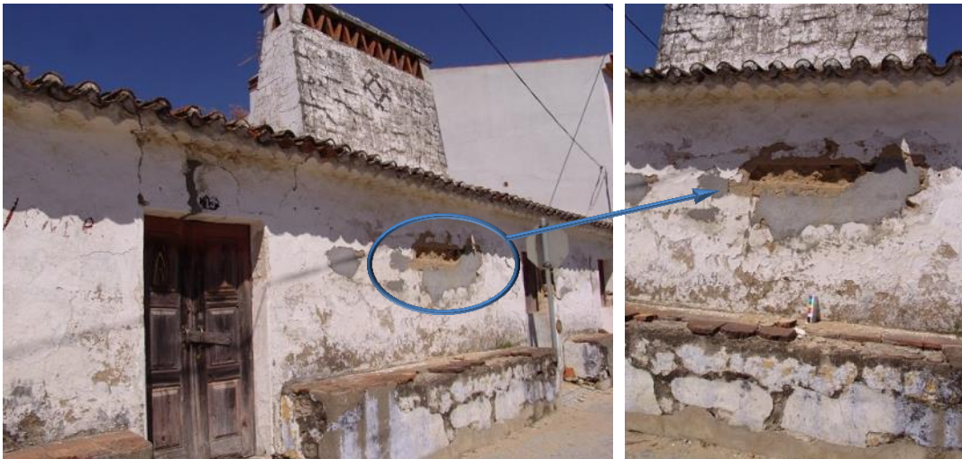
Figura 2.8. Utilização de argamassas cimentícias numa edificação em Avis, para colmatar a degradação superficial no paramento de taipa
