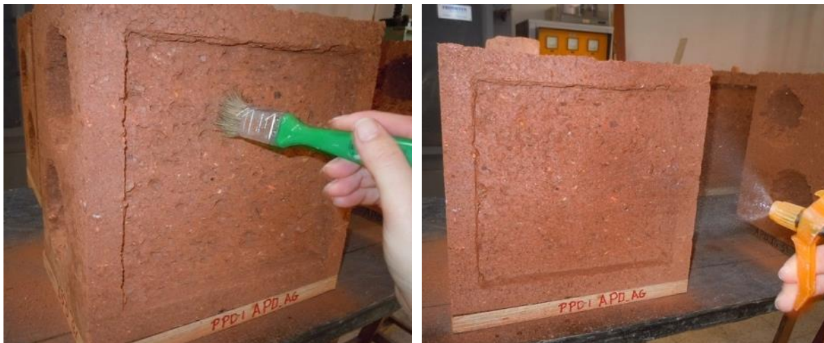
Figura 7.1. Preparação da superfície do defeito-padrão superficial antes de receber a argamassa de reparação: à esquerda, limpeza com pincel; à direita, humedecimento da superfície
