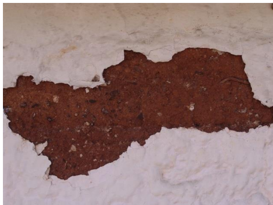
Figura 15.A. À esquerda, destacamento da camada de reboco visualizando-se os buracos devido à nidificação de insetos, e à direita, lintel em madeira (bastante ressequido) no vão da porta
