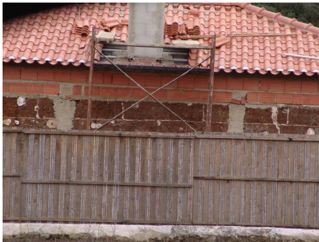
Figura 37.A. Ampliação em altura da edificação de taipa com recurso à utilização de tijolos furados
