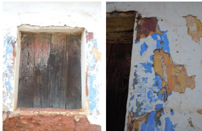
Figura 18.A. À esquerda, vão de janela com pormenor do lintel em madeira, e à direita, visualização das várias camadas de cal com pigmentos de várias cores
