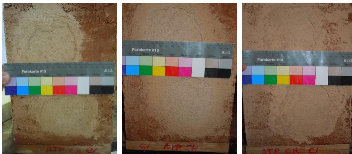
Figura 7.13. Anomalias nos blocos BPD: à esquerda, argamassa ATP_CA15 com fendas médias; ao centro, argamassa ATP_CH15 com fendas médias na zona de interface entre a argamassa e o bloco; à direita, argamassa ATP_CN15 com fendas médias na zona de interface entre a argamassa e o bloco
