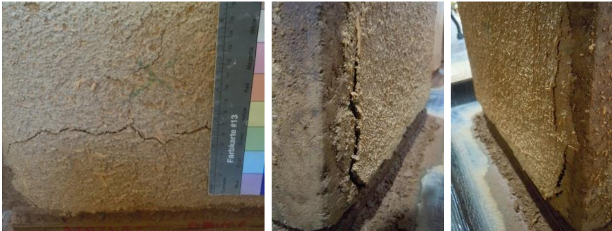
Figura 7.36. Bloco BVC com a reparação da argamassa ATP_CA15_Fib após terminada a fase de absorção de água por ascensão capilar, verificando-se destacamento da argamassa na zona inferior
