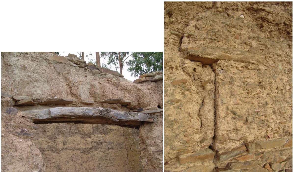
Figura 76.A. À esquerda, pormenor do lintel no vão da porta, e à direita, pormenor da pedra de xisto colocada entre os blocos de taipa
