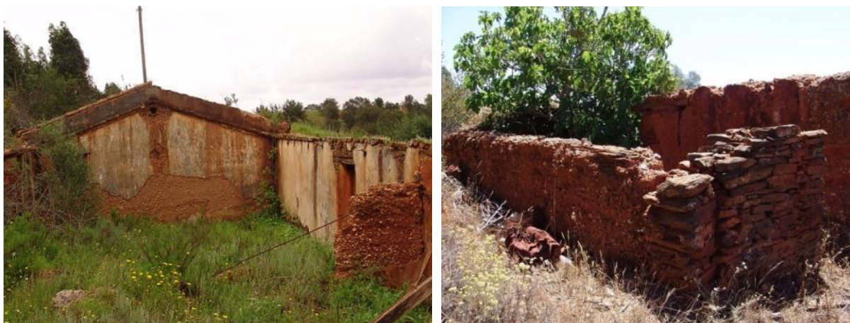
Figura 4.5. Edificação do Monte do Pá Danado, Odemira: à esquerda, fachada este e sul (principal) em taipa; à direita, paredes do edifício anexo, de taipa e alvenaria de xisto, acoplado à fachada a norte da edificação
