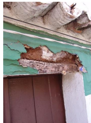
Figura 15.A. À esquerda, destacamento da camada de reboco visualizando-se os buracos devido à nidificação de insetos, e à direita, lintel em madeira (bastante ressequido) no vão da porta
