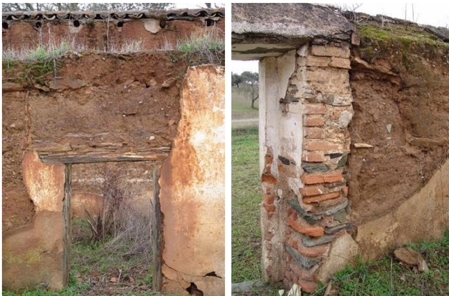
Figura 4.12. Edificação com a técnica construtiva da taipa construída no século XIX, Malhada do Monte Sal, Sobral da Adiça; introdução de fiadas de pedra no meio das camadas de taipa e reforço nos vãos de portas
