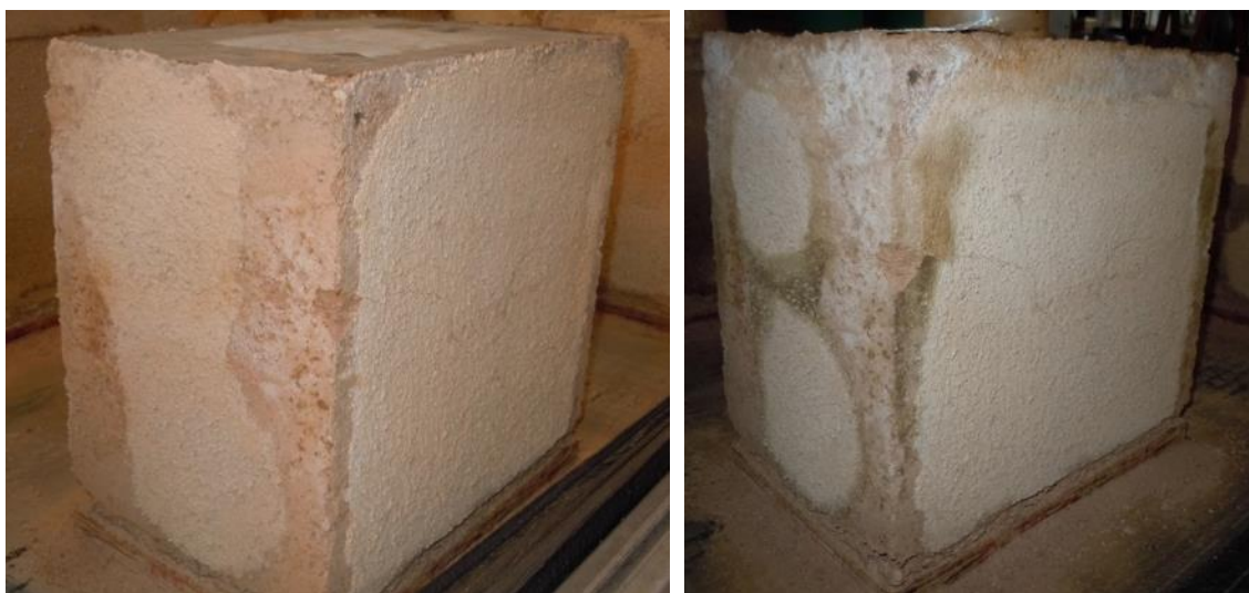
Figura 7.41. Bloco BVC com a aplicação da argamassa ATP_CH15, fase de absorção de água a partir do topo: à esquerda, antes de iniciar o 1º ciclo com fraco aparecimento de eflorescências; à direita, 60 dias após terminada a fase, com maior incidência de eflorescências em especial na taipa e na zona superior
