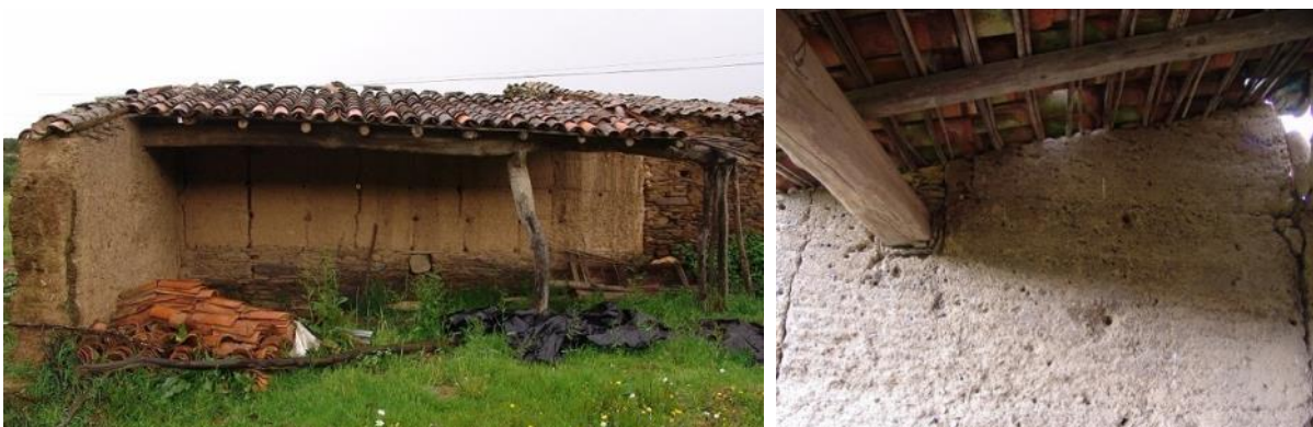
Figura 4.7. Edificação do Monte Val Chaim, Odemira: à esquerda, zona do telheiro, fachada sudoeste; à direita, estrutura da cobertura envolta com elementos de xisto na zona de entrega
