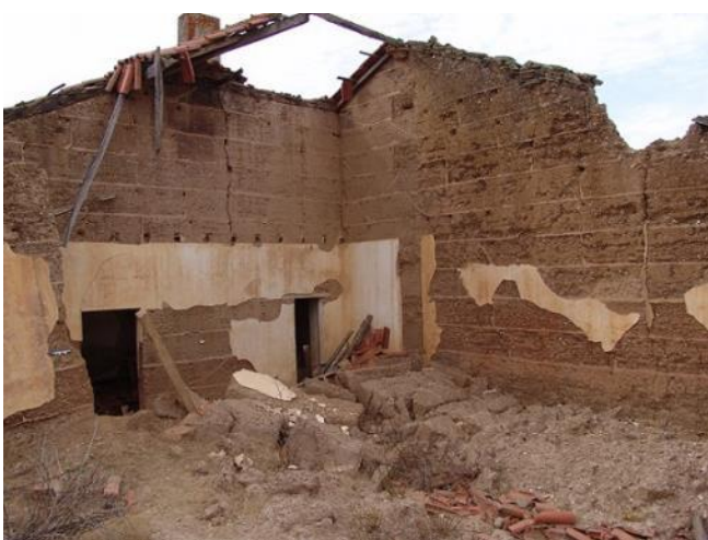
Figura 4.9. Escola do Barranco do Cai Logo, Ourique: em cima, fachada principal (noroeste); em baixo à esquerda, paredes interiores mostrando a zona de entrega da estrutura do soalho entre pisos; e em baixo à direita, pormenor do lintel de betão armado, da verga da janela e dos elementos em tijolo cozido furado na zona da entrega da estrutura da cobertura
