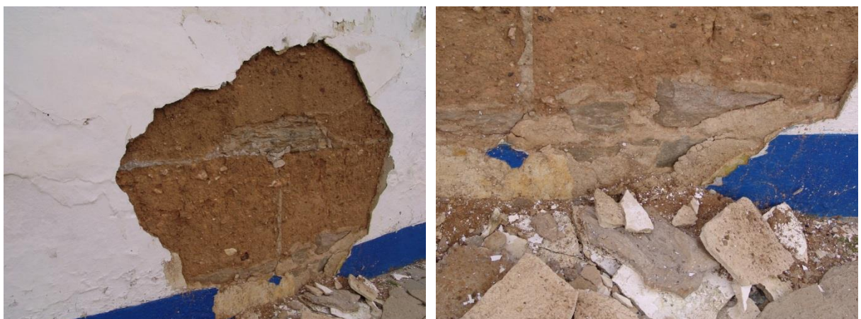
Figura 35.A. Destacamento do revestimento com pormenor do embasamento e introdução de elementos de pedra entre os blocos de taipa
