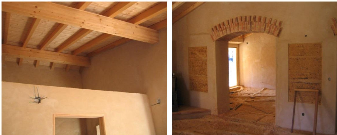
Figura 5.A. Construção em 2005: interior da edificação
