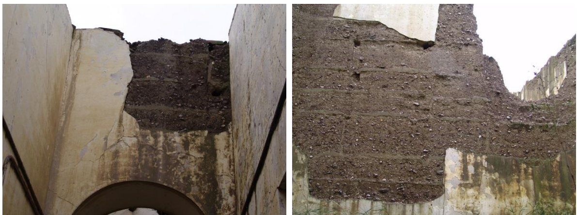
Figura 44.A. Paredes interiores da edificação, visualizando-se à direita a divisão do bloco de taipa em dois blocos
