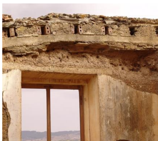
Figura 4.9. Escola do Barranco do Cai Logo, Ourique: em cima, fachada principal (noroeste); em baixo à esquerda, paredes interiores mostrando a zona de entrega da estrutura do soalho entre pisos; e em baixo à direita, pormenor do lintel de betão armado, da verga da janela e dos elementos em tijolo cozido furado na zona da entrega da estrutura da cobertura
