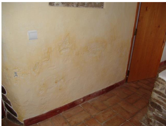
Figura 41.A. Humidades ascensionais: à esquerda, no interior do edifício; à direita, no exterior do edifício
