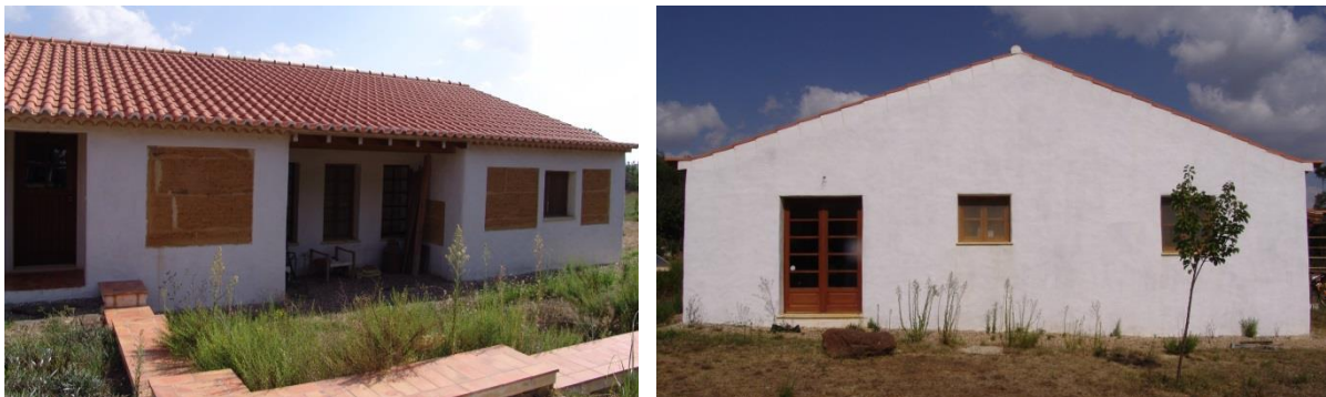
Figura 6.A. Em 2008: à esquerda, alçado lateral direito (noroeste); à direita, alçado posterior (noroeste) depois de revestido com argamassa de cimento
