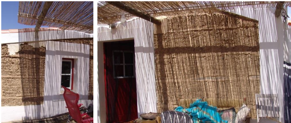
Figura 3.A. À esquerda, alçado principal visualizando a argamassa de reparação, e à direita, alçado principal com elementos de xisto inseridos na parede
