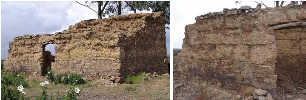
Figura 4.8. Edificação do Monte Se Deus Quiser, Almodôvar: à esquerda, fachada principal (sueste) e fachada lateral (nordeste); à direita, pormenor do embasamento, verga da porta em madeira e junta horizontal entre blocos de taipa com elementos de xisto
