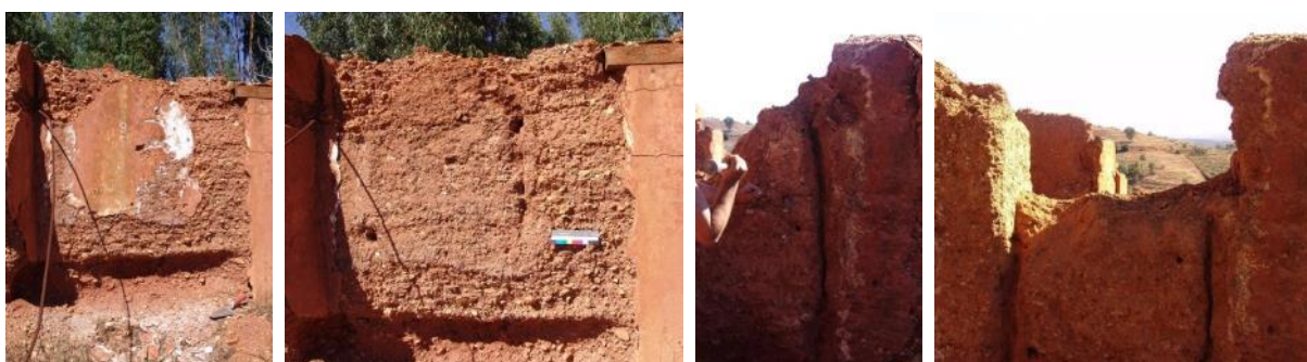
Figura 4.19. Sequência dos trabalhos para a recolha de amostras: remoção do reboco e corte da taipa em blocos
