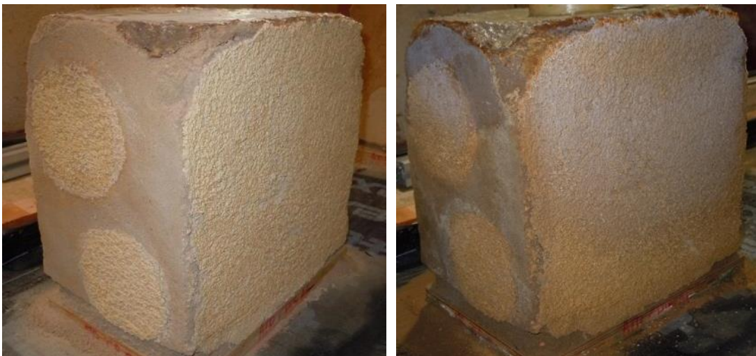
Figura 7.39. Bloco BAv com a aplicação da argamassa ATP_CP15 pelo método de absorção de água a partir do topo: à esquerda, antes de iniciar o 1º ciclo com algum aparecimento de eflorescências; à direita, após a finalização do 8º ciclo, com extensa visualização de eflorescências
