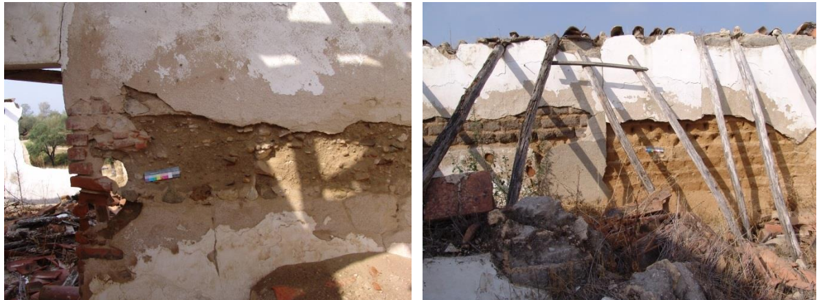
Figura 68.A. À esquerda, parede interior em taipa visualizando-se pedaços de cerâmica e cascalho angular de grandes dimensões, e à direita, parede do alçado posterior com a utilização de dois tipos de adobe
