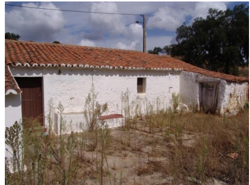
Figura 14.A. À esquerda, alçado lateral esquerdo (nordeste) com o revestimento bastante erodido, e à direita, alçado posterior (sudeste)
