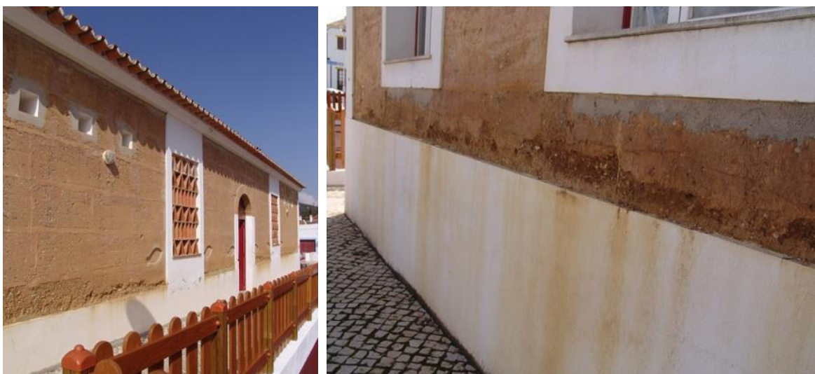
Figura 4.15. Erosão no paramento de taipa devido à existência de sais associado à ascensão capilar, Mercado de S. Luís, Odemira
