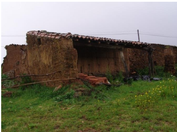
Figura 80. À esquerda, zona do telheiro, e à direita, pormenor da entrega da estrutura de cobertura na parede de taipa e visualização de uma fenda vertical
