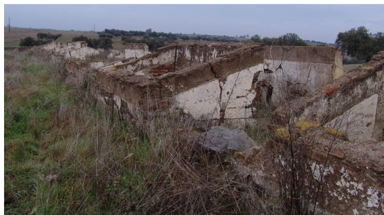
Figura 47.A. Edifício do corpo 2, verificando-se a utilização de algumas argamassas cimentícias
