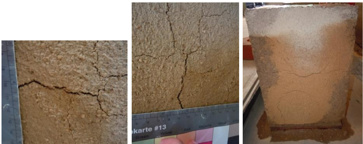
Figura 7.32. Bloco BVC com a argamassa ATP_CH15 após terminado o método de absorção de água por ascensão capilar; fissuras nas argamassas e na taipa
