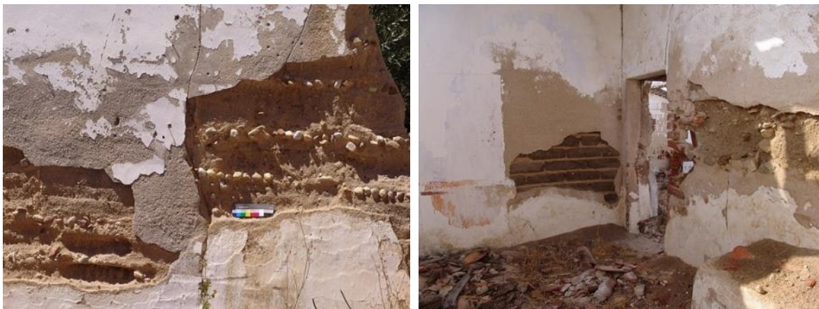
Figura 4.4. Edificação do Monte das Covas, Avis: à esquerda, paramento com a técnica da taipa arenosa, com juntas horizontais de cascalho rolado; à direita, parede com a técnica do adobe (à esquerda) e taipa arenosa incluindo cascalho angular (à direita)
