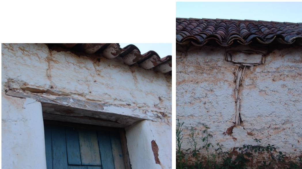
Figura 20.A. À esquerda, vão de janela com pormenor do lintel em madeira visualizando-se a utilização da pedra em cima da madeira, e à direita, introdução de xisto na parede de taipa
