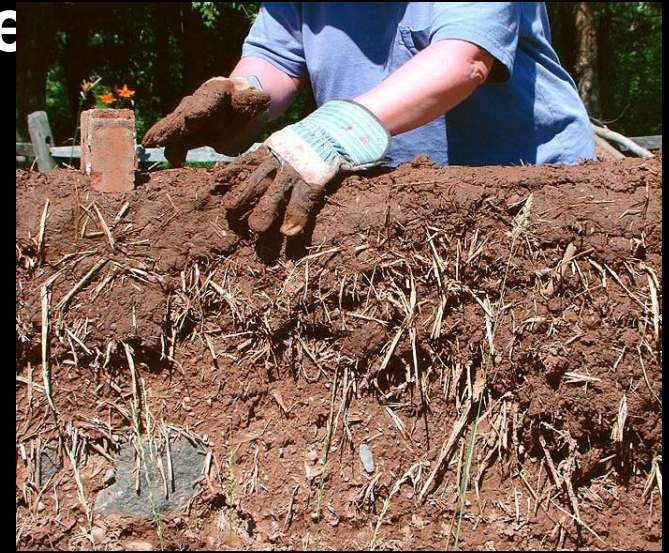
construction de mur en bauge (foto: Wikipedia)
