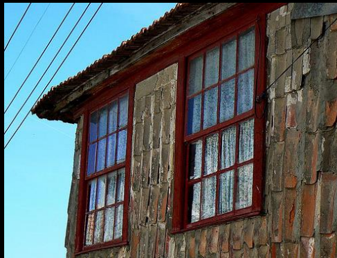
étage élevée en torchis recouverte avec des carreaux céramiques, Porto, Portugal (foto: peregrino27)
