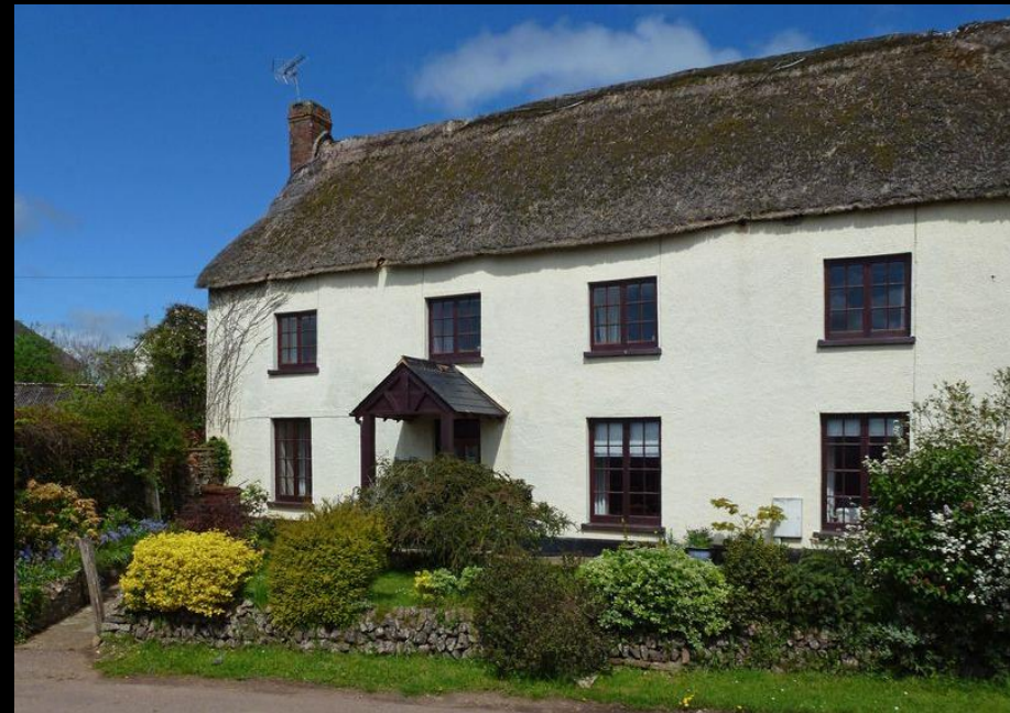
Maison en bauge , Angleterre (foto: Whitton and Laing)
