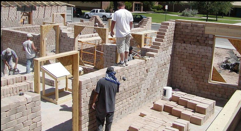
construction avec BTC, Texas, 2006 (foto: Dan Powell)
