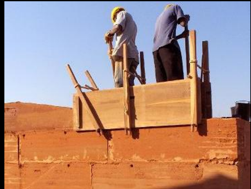
Construction de bâtiment em pisé, au Portugal (foto: Miguel Mendes, arquiteto)
