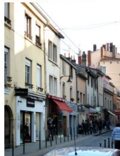
Lyon, quartier de la Croix-Rousse. La plupart des constructions de la rue sont encore en pisé. © Sébastien MORSEZ, CRAI 1972
