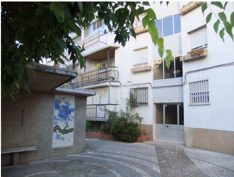
Fig. 05: zona de entrada de edifício de interesse social em Olivais Norte, Lisboa, projeto dos arquitetos Nuno Teotónio Pereira e António Pinto de Freitas.
