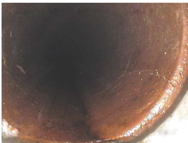
(b) Exemplo do registo de uma observação do tipo BAB (fissura longitudinal)
