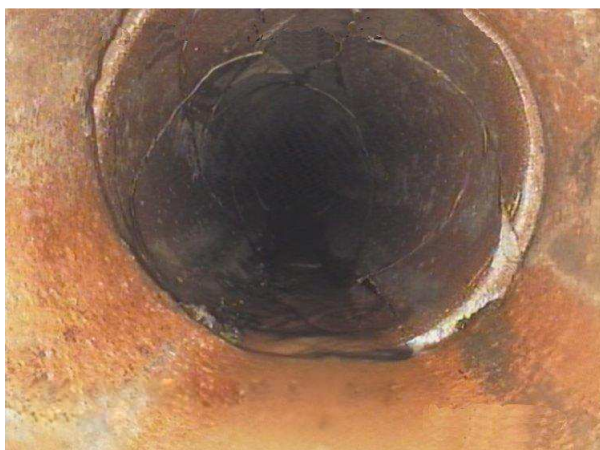
(a) Exemplo do registo de uma observação do tipo BAB (fissura longitudinal)
