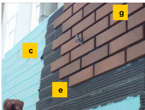
Fig. 3 – Sistema ETICS com isolante com poliestireno expandido extrudido (XPS)
