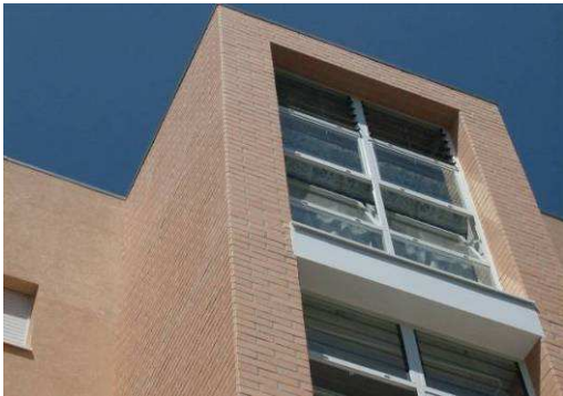
Figs. 6 e 7 – Aplicação de ETICS com acabamentos de ladrilhos cerâmicos em moradias
