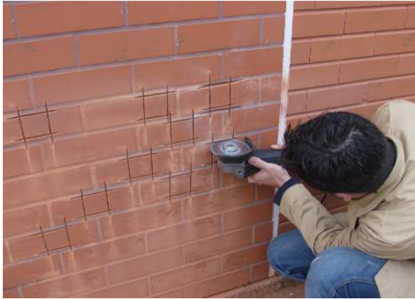
Fig. 10 – Execução das incisões para realização do ensaio de aderência
