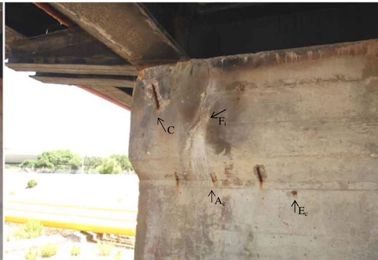
Fig. A.66: Face oeste: após remoção do betão delaminado
