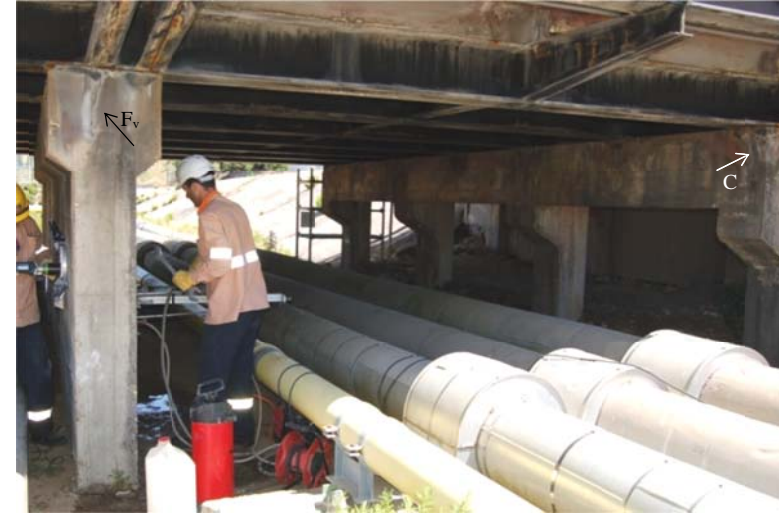
Fig. A.54: Face oeste da viga de travamento e pilar sul
