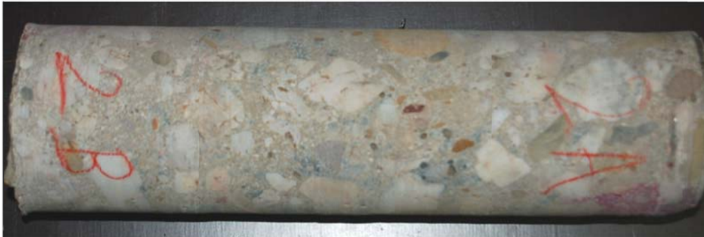
Carote 2: Viaduto 1; Pilar Parede Nº3; ( \text{Ø} = 92 \text{ mm} ; comp. máx= 332 mm); Dimensão do agregado > 1/3 \text{ Ø}
