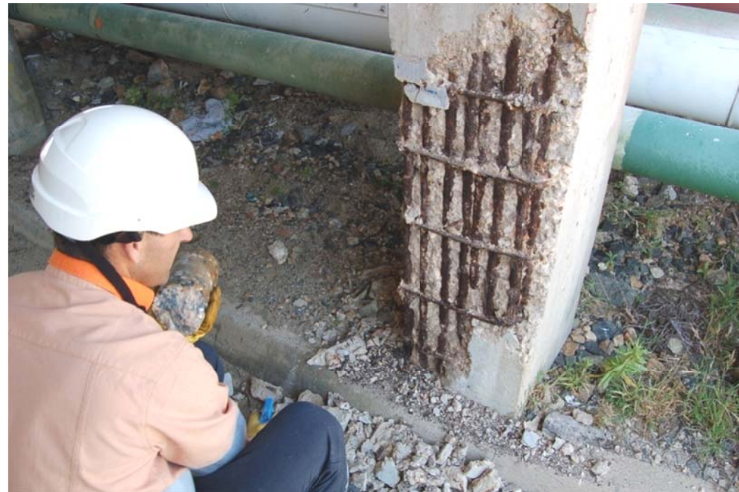
Fig. A.6: Remoção do betão de recobrimento delaminado na face oeste
