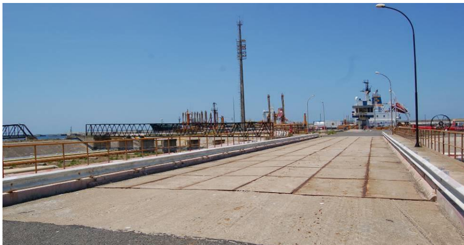
Figura 17: Vista geral da superfície do tabuleiro dos viadutos
