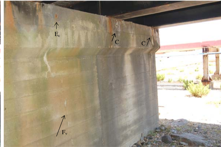
Fig. A.32: Extremidade sul da face oeste
