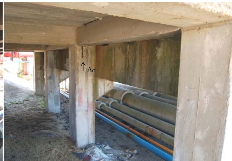
Fig. A.50: Face este da viga de travamento
