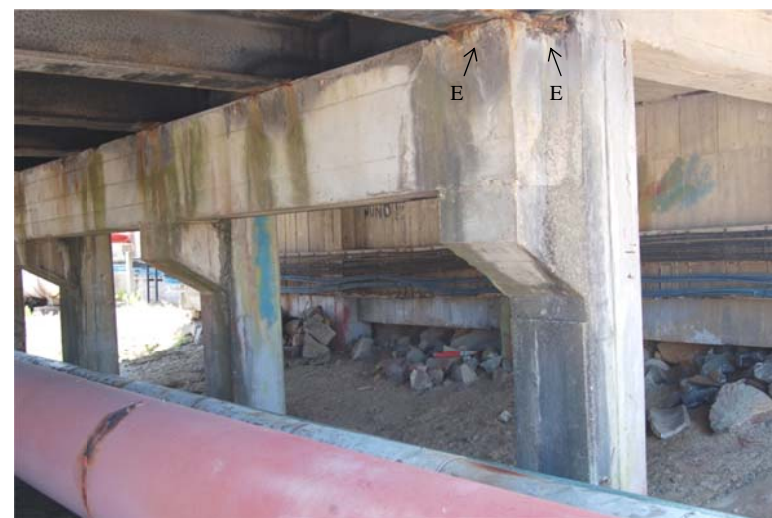
Fig. A.9: Pilar norte, face este da viga de travamento
