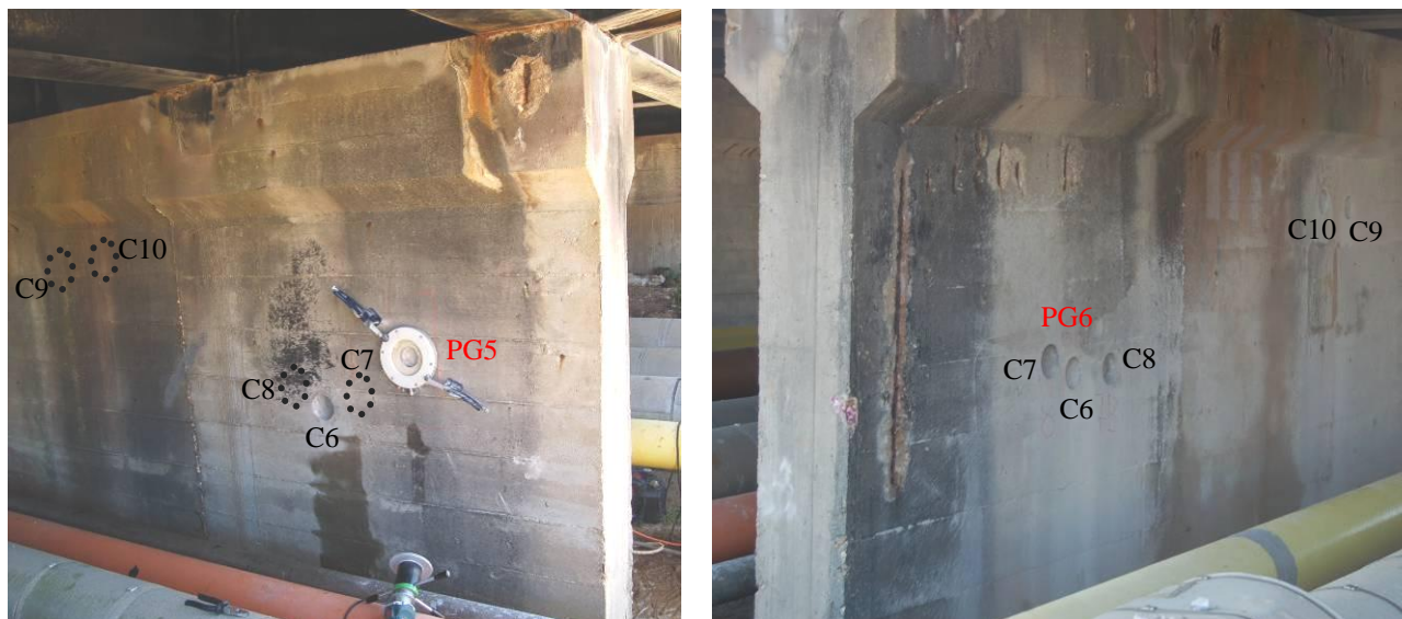
a) Face oeste do pilar parede n°7 – Viaduto 4/5
