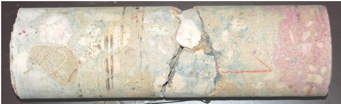
Figura 27: Carote 1: Viaduto entre o posto de acostagem 9/10; Pilar Parede Nº3; ( \varnothing = 101 mm; comp. máx= 330 mm); Dimensão do agregado > 1/3 \varnothing
