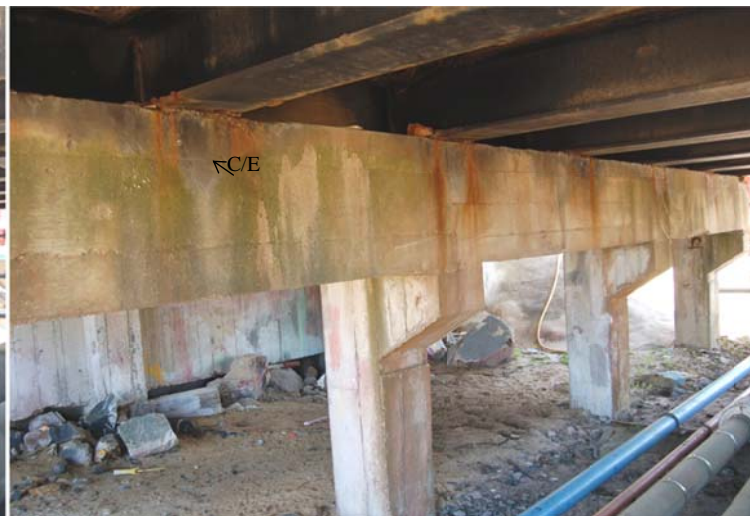
Fig. A.49: Face oeste da viga de travamento
