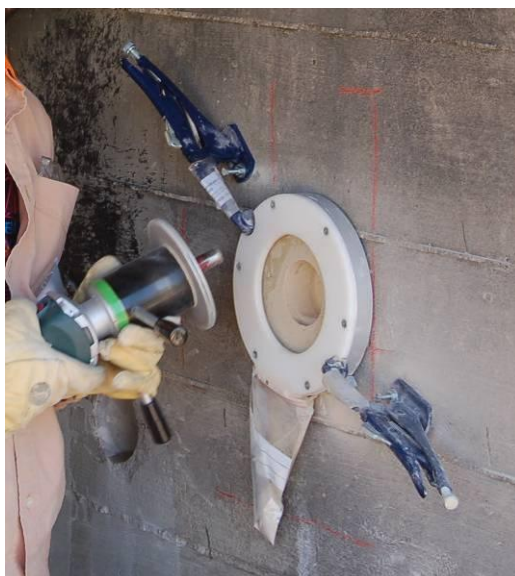
Figura 28: Colheita de amostras na face este do pilar parede 3, do viaduto entre os postos de acostagem 9/10
