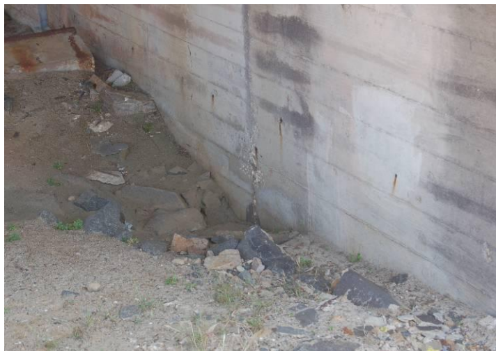
b) Aspecto do betão armado da zona enterrada
