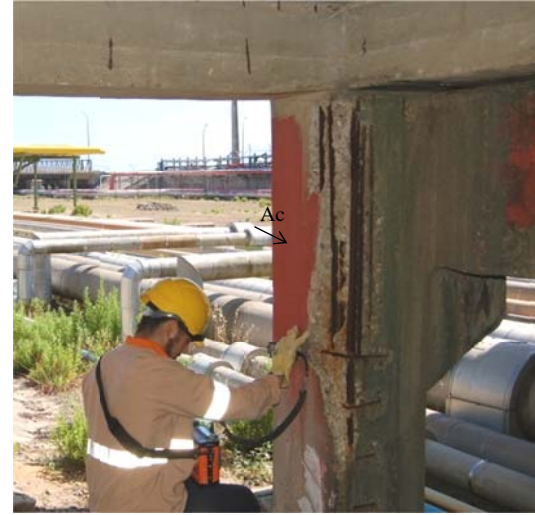
Fig. A.53: Pilar sul, face este
