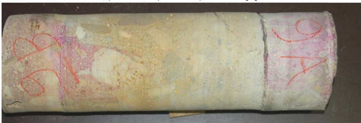
Carote 9: Viaduto 2; Pilar Parede N°7; ( \varnothing = 92 mm; comp. máx= 305 mm); Dimensão do agregado > 1/3 \varnothing
