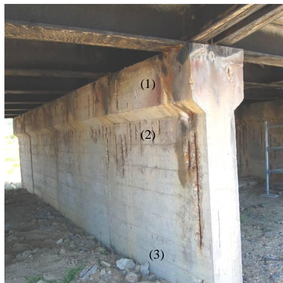
Figura 22: Medição in situ da espessura do recobrimento directamente sobre a armadura exposta
