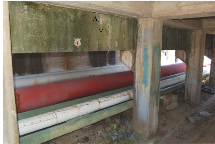
Fig. A.2: Face oeste da viga de travamento
