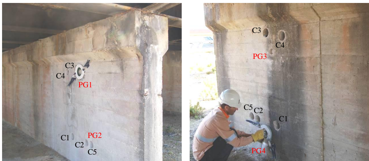
a) Face oeste do pilar parede nº3 – Viaduto 9/10
