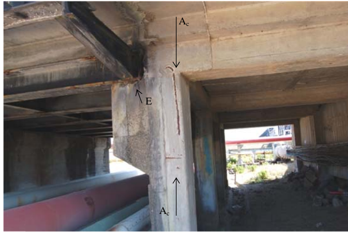
Fig. A.1: Pilar norte, face norte
