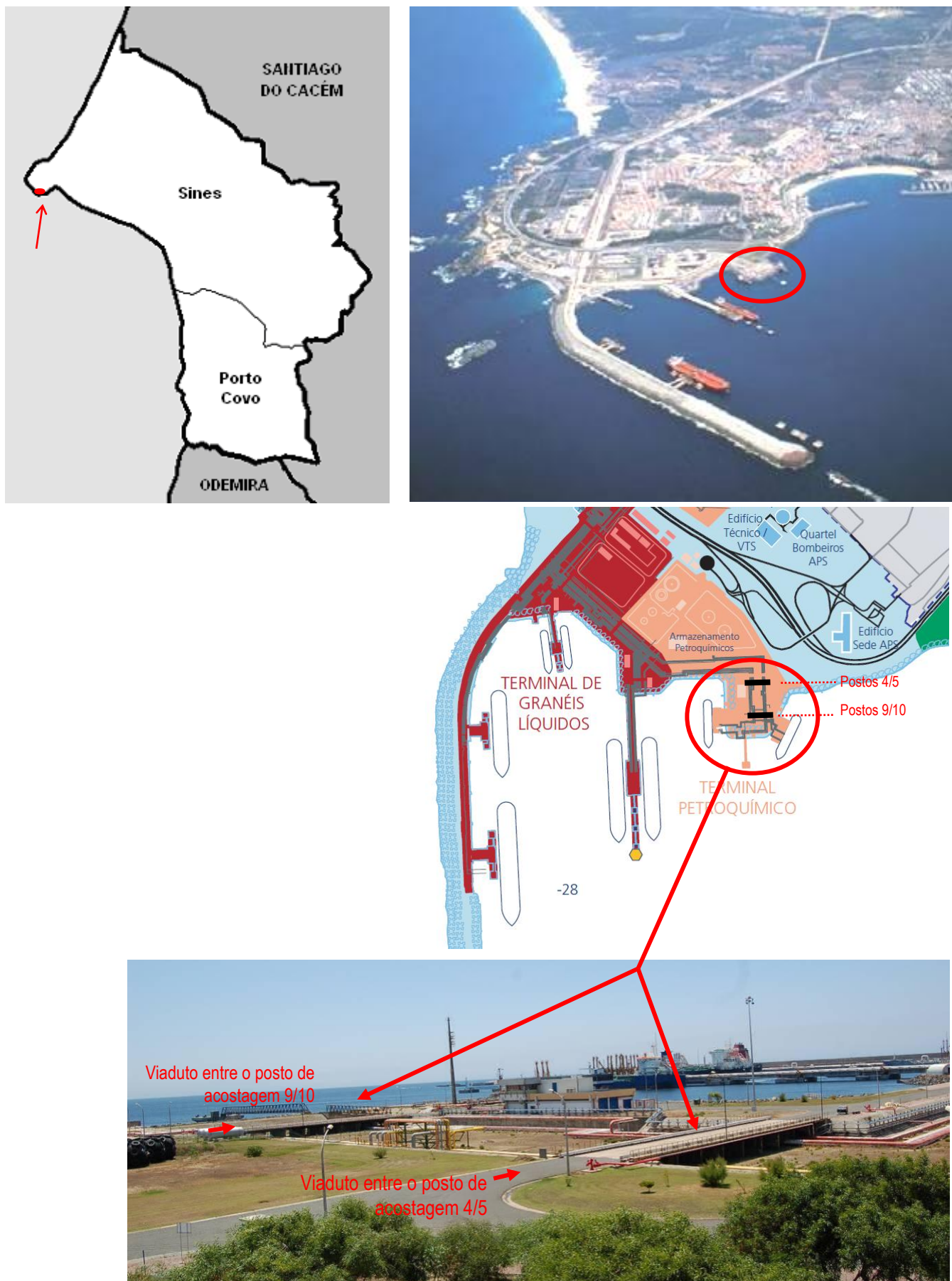
Figura 1: Localização e vista geral dos viadutos
