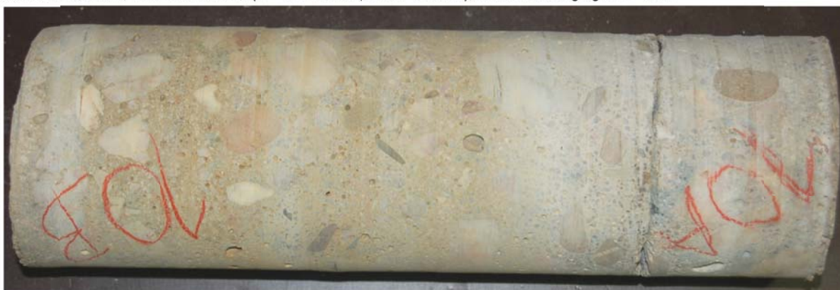
Carote 10: Viaduto 2; Pilar Parede N°7; ( \varnothing = 92 mm; comp. máx= 303 mm); Dimensão do agregado > 1/3 \varnothing
