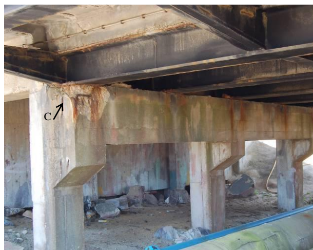
b) Rotura por corte
