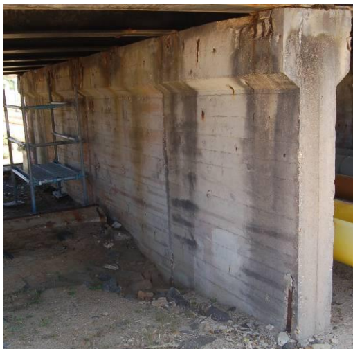
a) Pilar parede nº6
