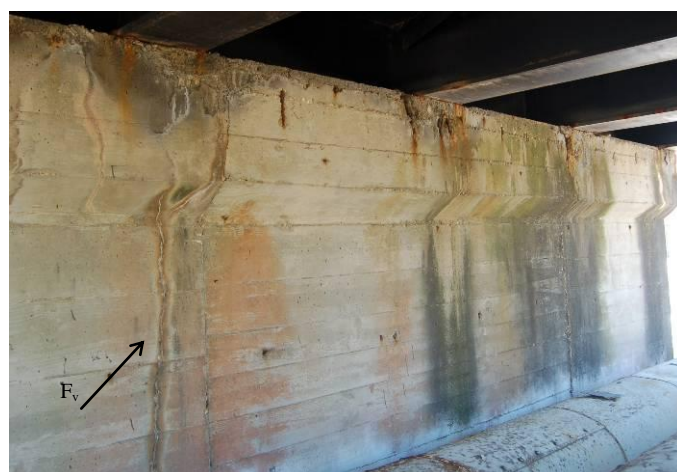
Figura 8: Fissura vertical nos pilares parede com prolongamento na zona de espessamento ( F_v )
