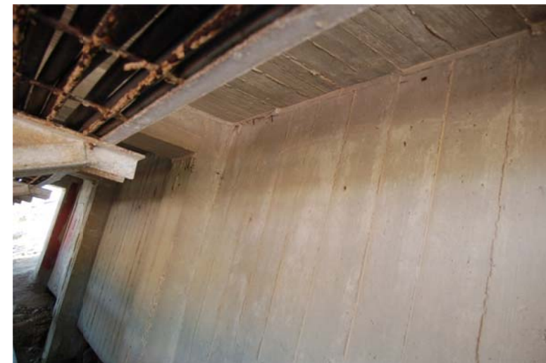
Fig. A.90: Pilar parede junto ao terreno
