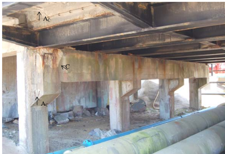
Fig. A.48: Pilar norte e face oeste da viga de travamento
