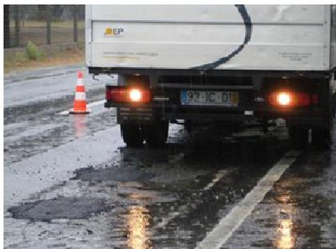
**Fig. 3.** Aplicação das misturas betuminosas a frio de reparação rápida (sob condições adversas) “*throw-and-roll*”.
