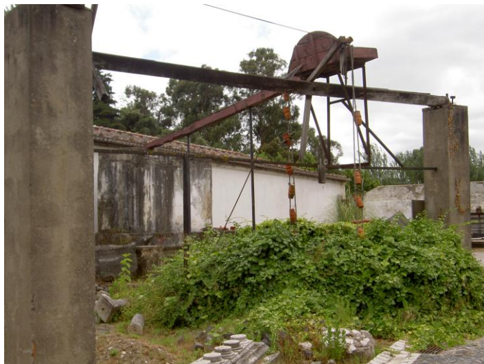
Figura 61 – Poço P3(MC), Museu da Cidade (Campo Grande)
