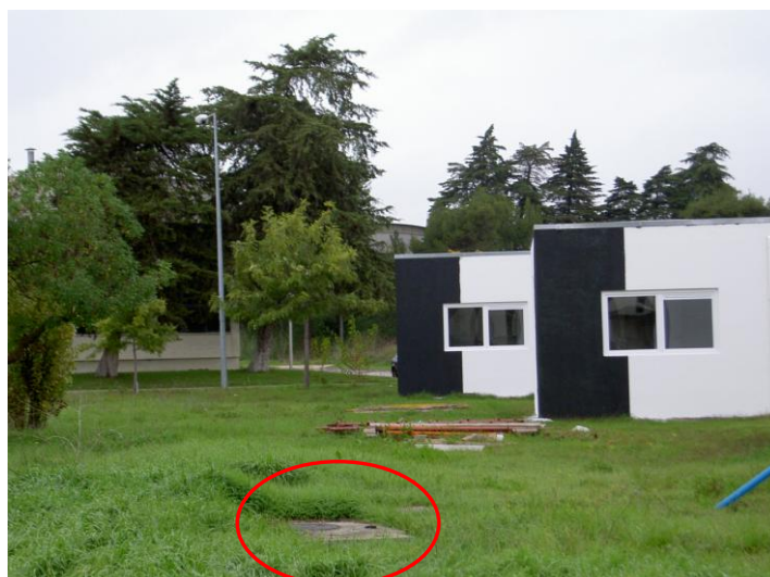
Figura 58 – Poço P1(CF), LNEC (junto ao campo de futebol)
