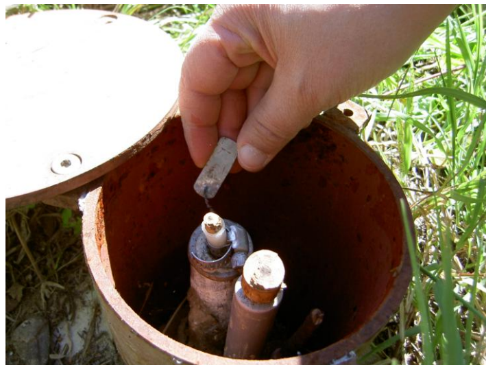
Figura 60 – Piezómetros PZ1, PZ2 e PZ3, LNEC (a N do PHM)
