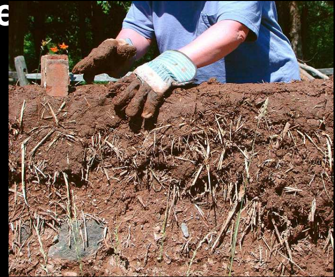
construction de mur en bauge
