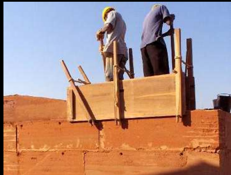
Construction de bâtiment em pisé, au Portugal (foto: Miguel Mendes, arquiteto)
