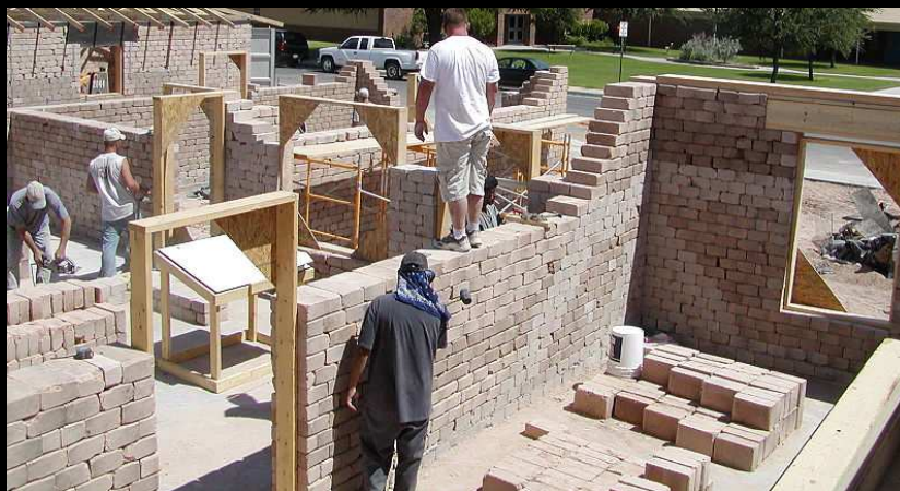
construction avec BTC, Texas, 2006 (foto: Dan Powell)
