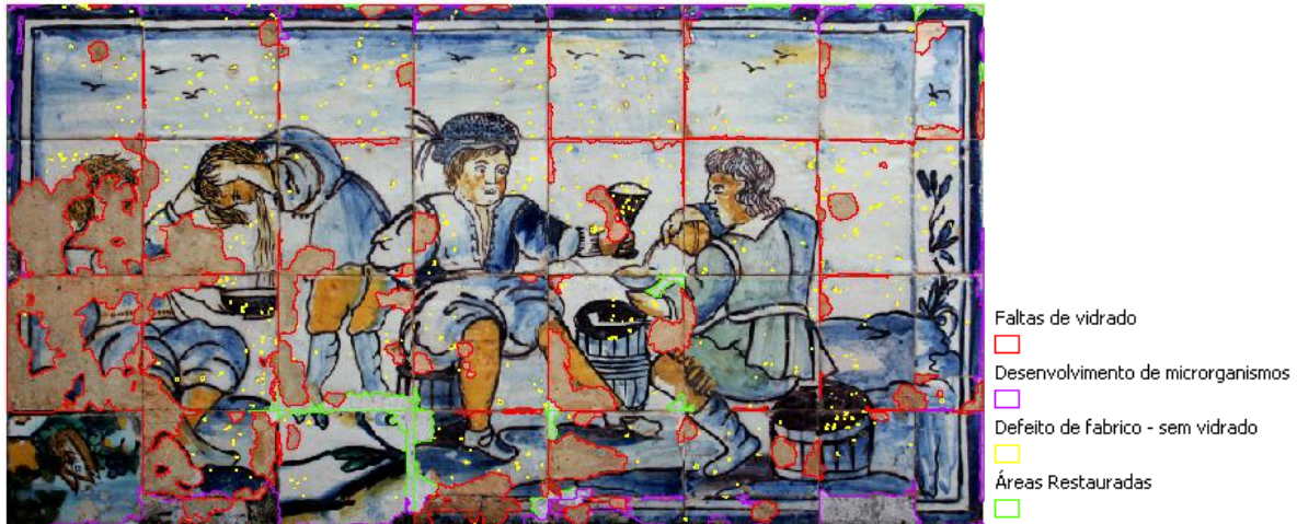
Figura 1 – Painel de azulejos com sobreposição dos vectores correspondentes às patologias identificadas na classificação, após a edição manual.
