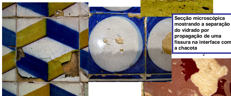
...e provoca também o empolamento e queda dos vidrados, além de outras degradações de natureza química e biológica.
