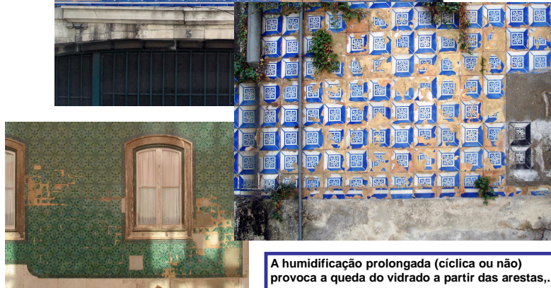
... provoca a formação e destacamento do “craquelé” (queda do vidrado em mosaico),...
