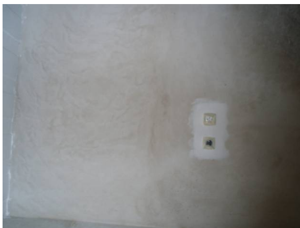
Fig. A4 – Pormenor do reboco aplicado na parede interior da casa
