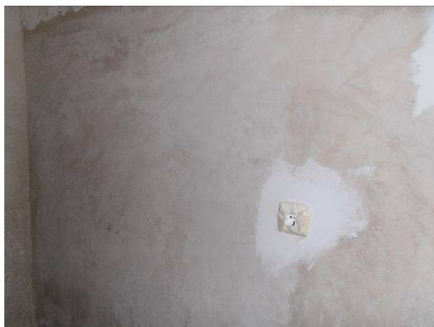
Fig. A2 – Reboco recentemente aplicado numa parede de interior de uma habitação
